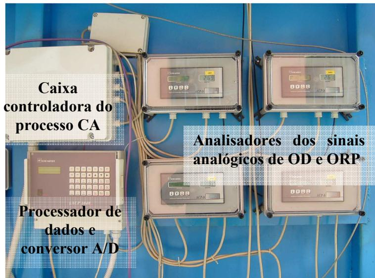
Figura 14 – Dispositivo de controle do processo de ciclos alternados
