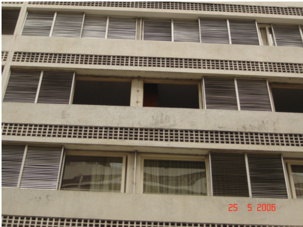
Foto 5.7.3 – Remoção de montante de fechamento das folhas de correr tipo veneziana.
