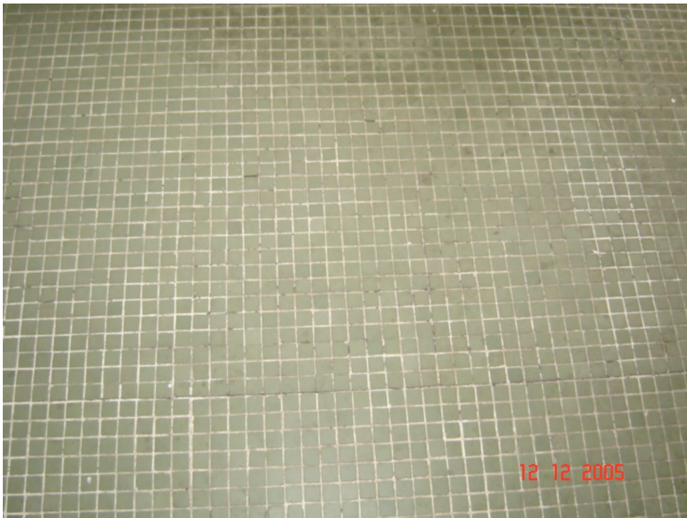
Foto 5.6.2. – Desgaste abrasivo do piso tipo pastilha do ambiente.
