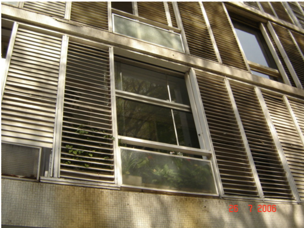
Foto 5.7.20 – Substituição de caixilharia composta por grandes painéis de madeira por painéis de vidro temperado.
