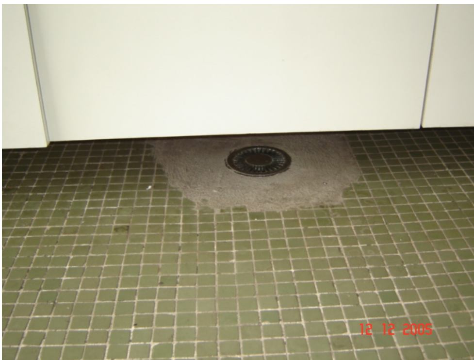
Foto 5.10.7. – Insuficiência de ralos sifonados nas áreas molhadas dos apartamentos.
