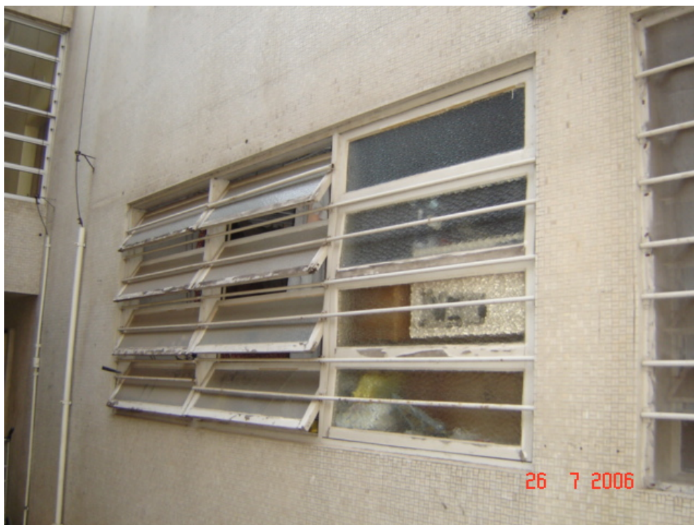
Foto 5.7.17 – Barras horizontais fixadas nas janelas tipo basculante.
