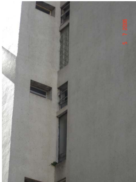
Foto 5.5.2 – Substituição do vedo de bloco de vidro sob a esquadria do sanitário.
