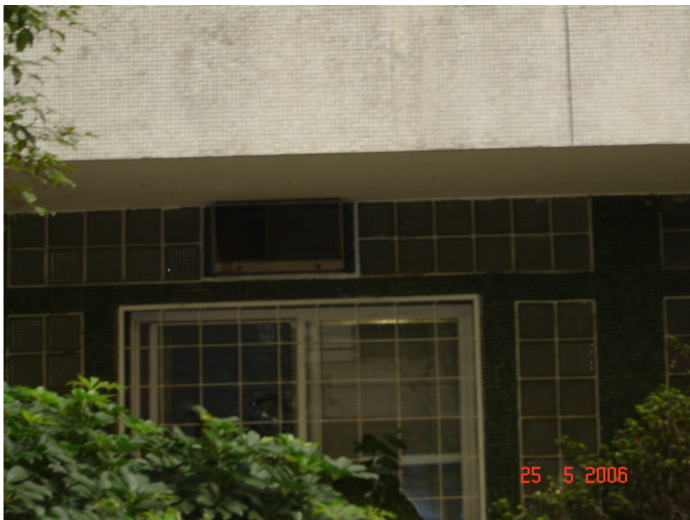
Foto 5.5.9 – Retirada de bloco de vidro para iluminação dos apartamentos localizados no térreo.
