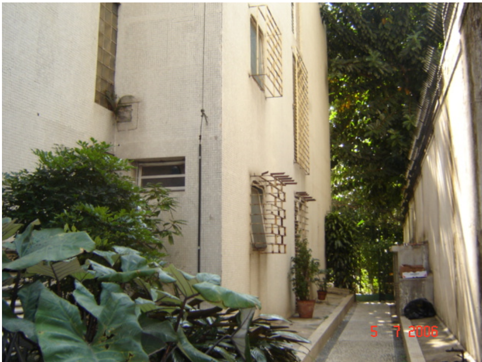
Foto 5.7.18 – Grades de segurança de ferro adotadas nos apartamento do 1º e 2º pavimentos sem considerar um único padrão.
