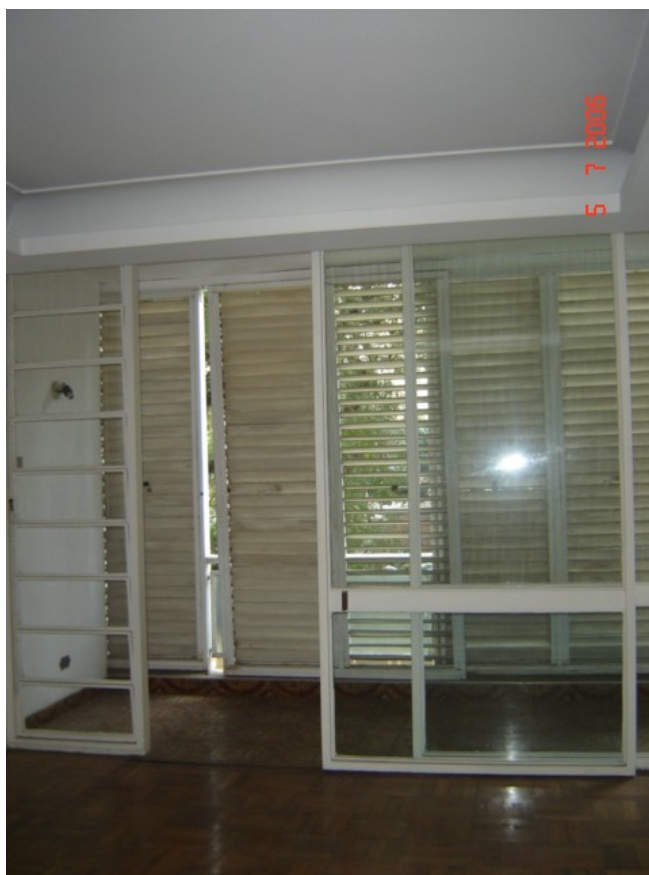
Foto 5.6.1 – Substituição do piso original de pastilha cerâmica (apto. 1A).
