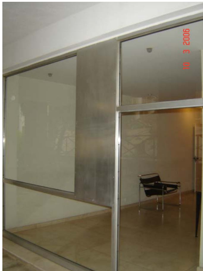
Foto 5.6.3 - Substituição desnecessária do piso de granito existente.
