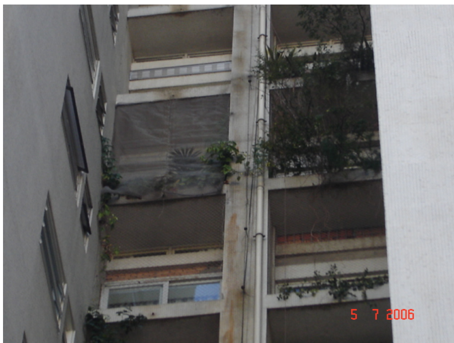
Foto 5.7.7 – Eliminação da janela de maneira generalizada sobre a esquadria principal.
