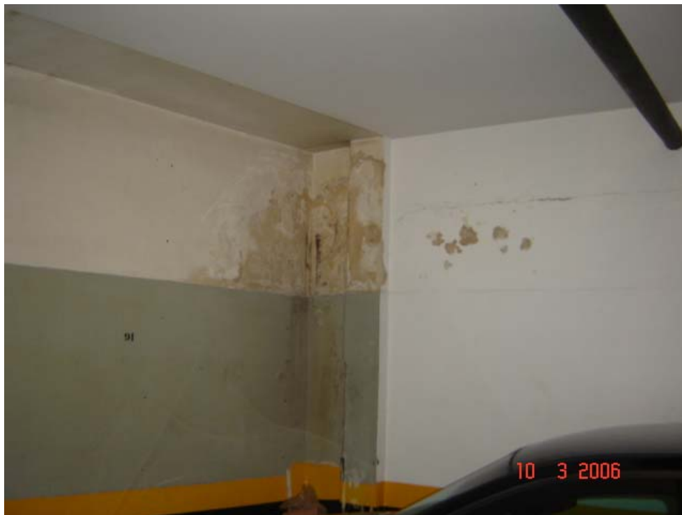
Foto 5.5.4 - Trincas no encontro da parede com as vigas de concreto.
