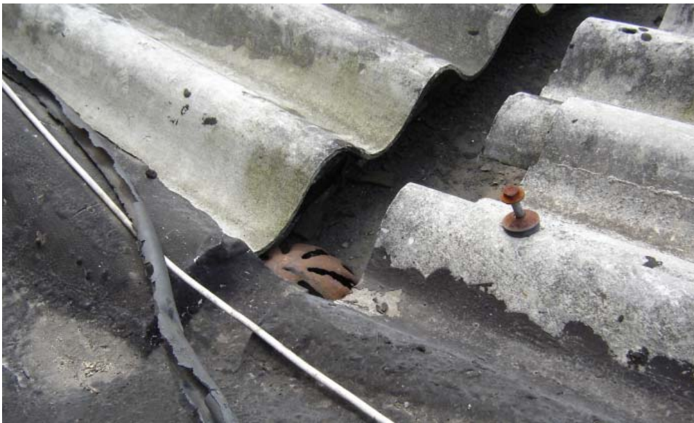
Foto 5.4.2. – Dimensionamento insuficiente do ralo para escoamento das águas pluviais.
