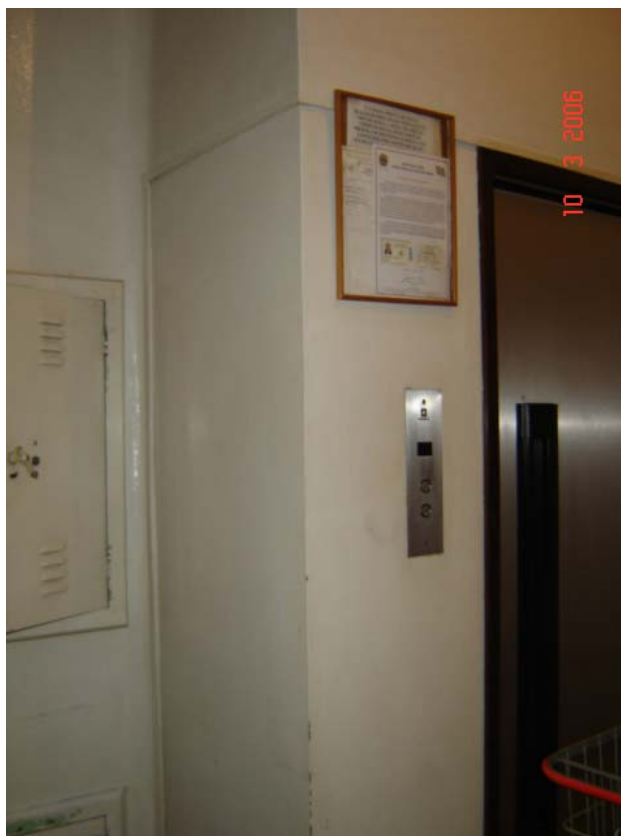
Foto 5.8.3 - Demolição do revestimento de madeira sobre as paredes junto ao elevador no pavimento Térreo.
