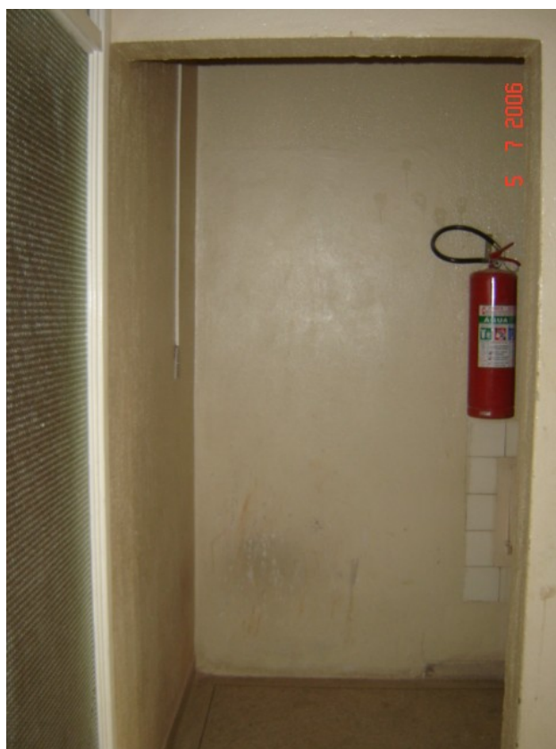
Foto 5.5.7 – Eliminação da porta de acesso à cozinha do apartamento.
