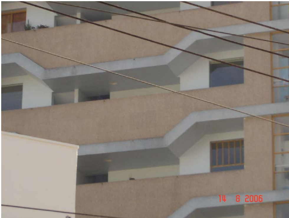
Foto 5.7.9. – Aspecto visual deficiente das esquadrias localizadas na sala de jantar decorrente de modificações.
