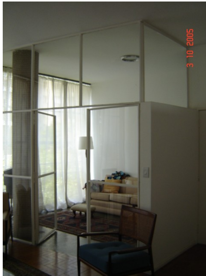
Foto 5.7.11. – Aspecto visual deficiente das esquadrias localizadas no estar social decorrente da eliminação das esquadrias do jardim de inverno.
