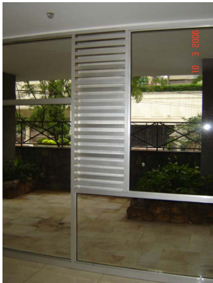
Foto 5.7.5 - Cancelamento da ventilação do hall social com alteração da caixilharia de alumínio.
