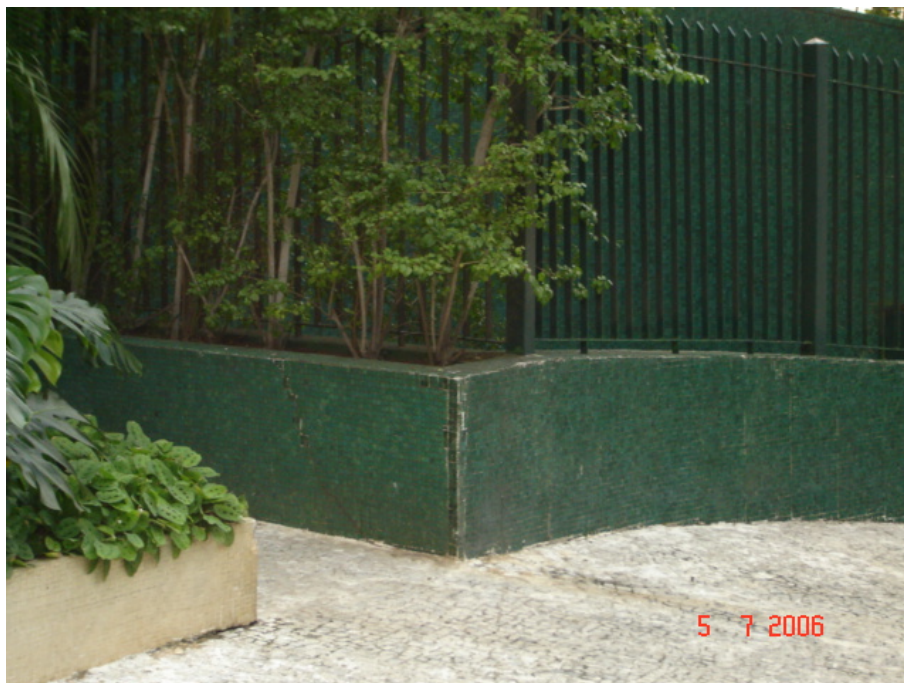
Foto 5.8.1 – Reposição pontual de pastilhas de coloração diferente da original.
