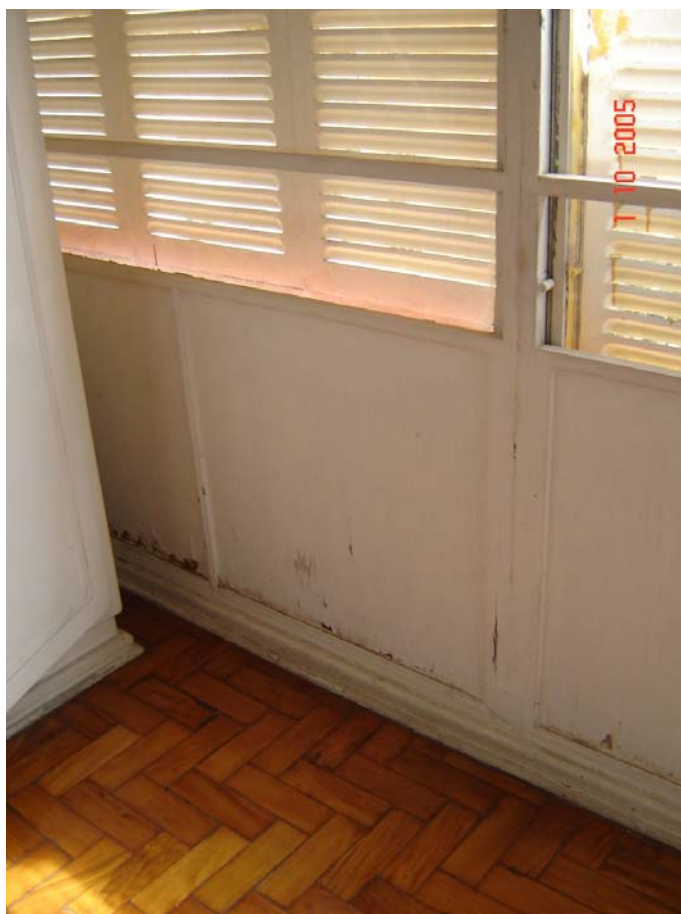
Foto 5.5.5. – Elemento de composição das esquadrias dos dormitórios com o emprego de madeira tipo compensada de pequena espessura.
