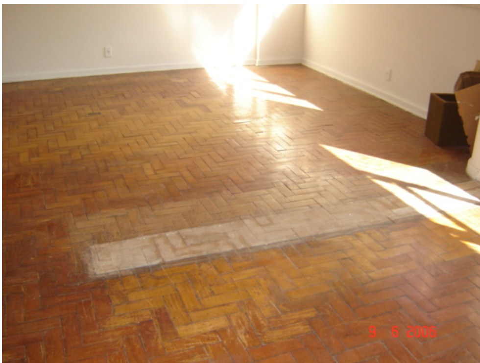
Foto 5.6.3 – Degradação do piso com tacos de madeira na sala social.
