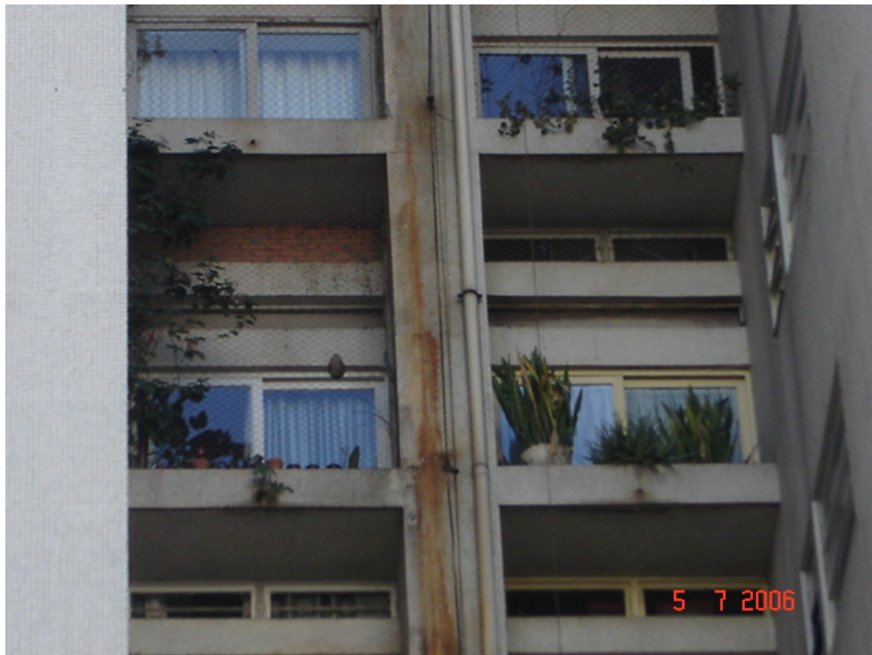
Foto 5.7.6 – Eliminação da janela sob a floreira.
