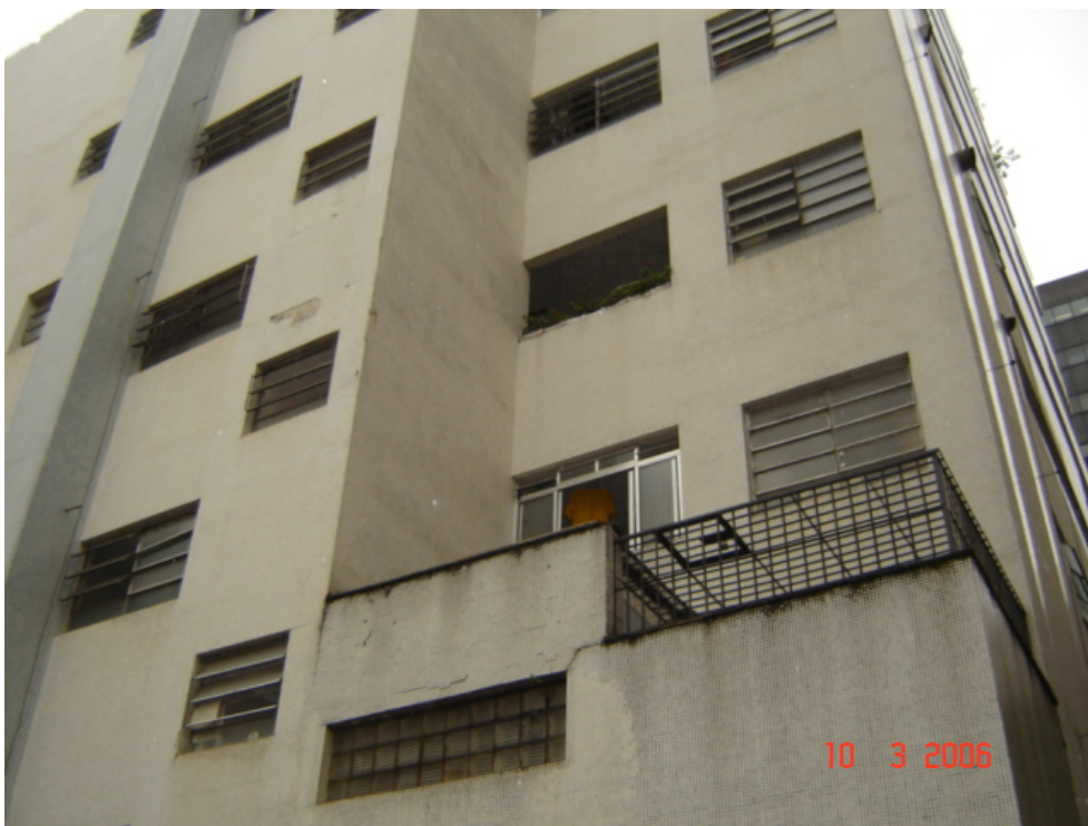
Foto 5.8.6 - Degradação generalizada dos revestimentos de pastilha cerâmica das fachadas noroeste e sudoeste.
