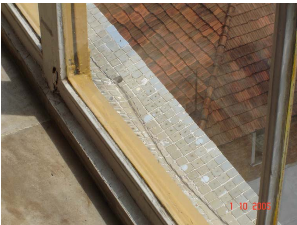
Foto 5.9.6. – Aspecto visual deficiente das instalações aparentes de telefonia.
