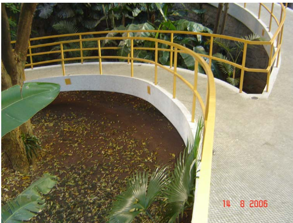
Foto 5.1.1. – Falta de drenagem no jardim frontal entre os dois edifícios.
