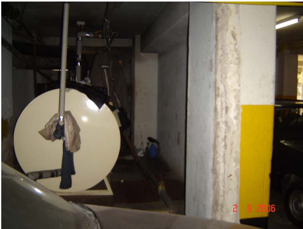
Foto 5.5.3 – Ausência de reconstrução de alvenaria.
