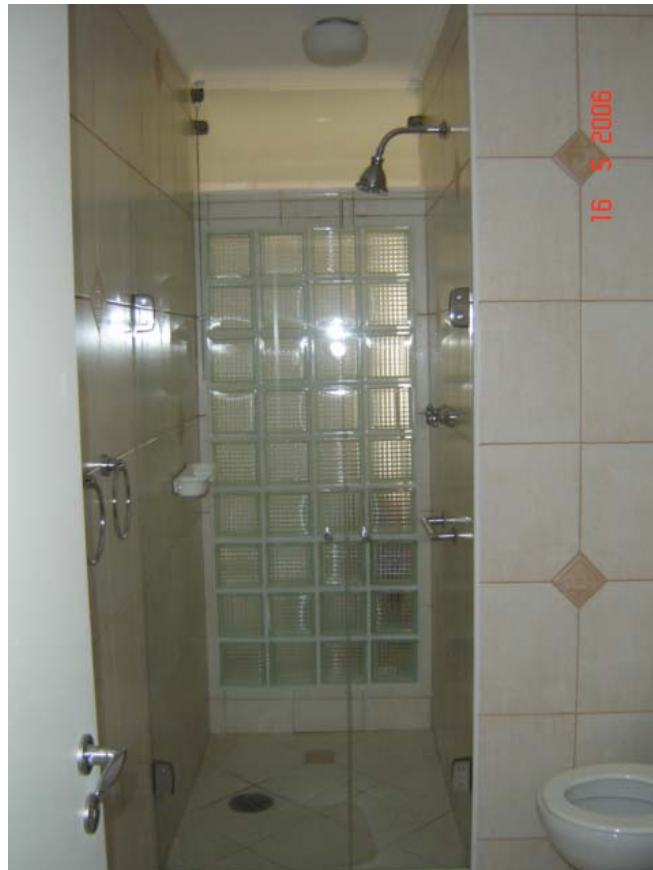
Foto 5.6.1 – Substituição do piso de cerâmica esmaltada (apto. 92).
