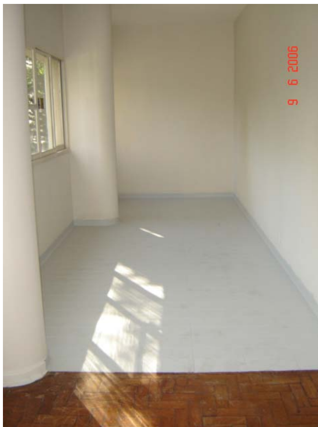
Foto 5.6.1 – Substituição do piso de cerâmica esmaltada (apto. 92).
