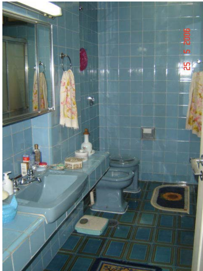
Foto 5.6.2 – Substituição do piso de cerâmica esmaltada.
