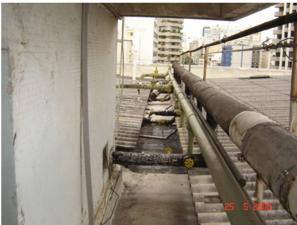
Foto 5.4.1 – Transferência das tubulações de maneira aparente.
