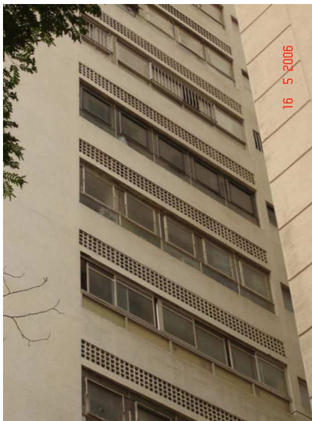
Foto 5.7.1 – Substituição de caixilharia, de maneira generalizada.
