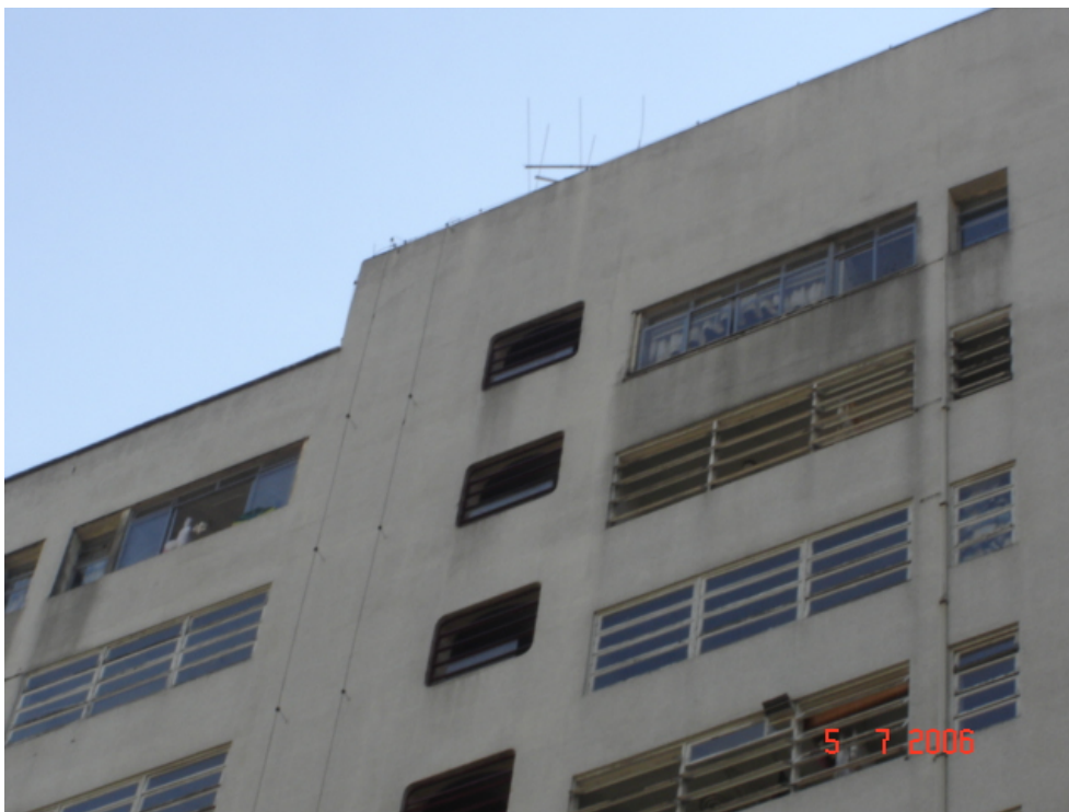
Foto 5.7.1 – Substituição de caixilharia por outra com desenho diferente.
