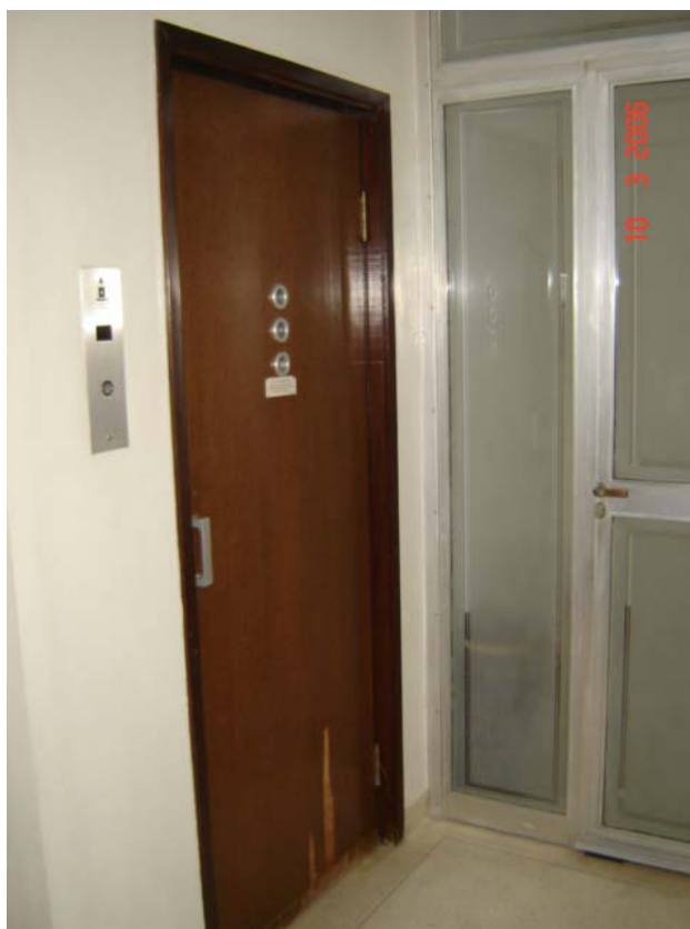
Foto 5.8.4 - Demolição do revestimento de madeira sobre as paredes junto ao elevador do hall dos apartamentos.
