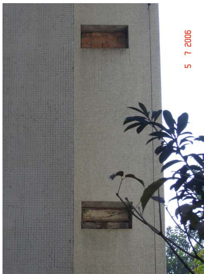
Foto 5.7.5 – Eliminação da janela do sanitário do apartamento N° 41.
