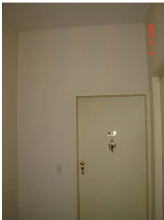
Foto 5.7.9 – Remoção de esquadria de chapa de aço sobre a porta.
