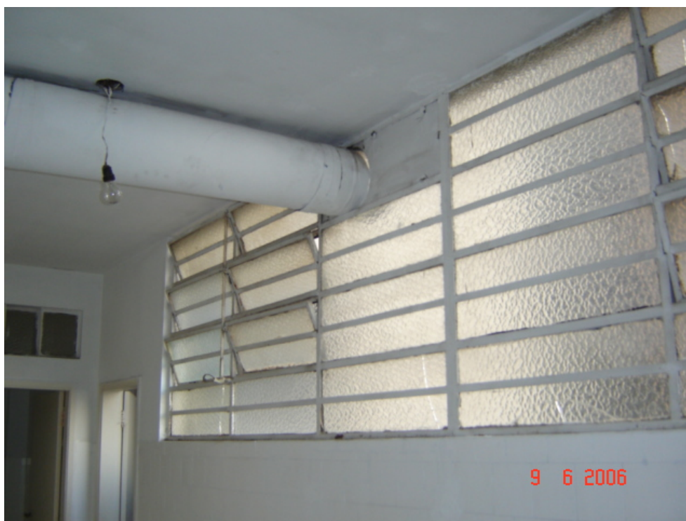
Foto 5.7.5 – Introdução de barra horizontal em todas as janelas tipo basculante na esquadria da área de serviço.
