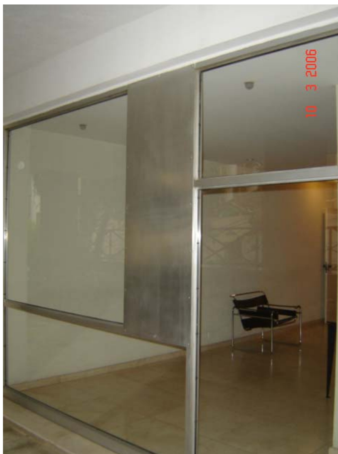
Foto 5.8.2 - Destruição do revestimento cerâmico original.
