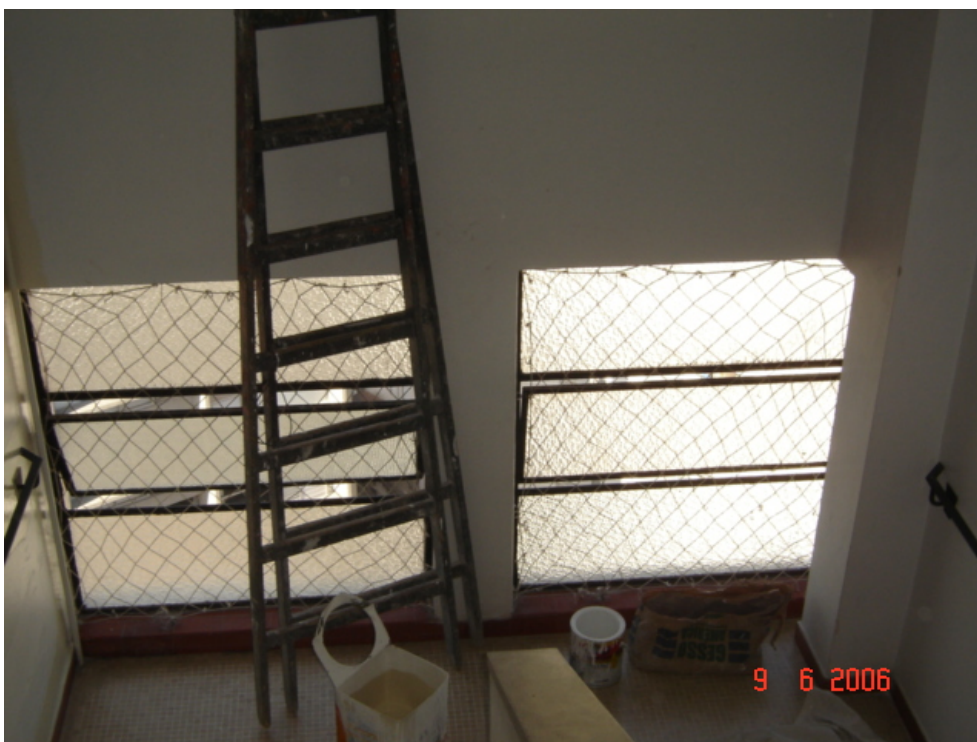
Foto 5.7.11 – Introdução de tela de proteção na esquadria do patamar da escada.
