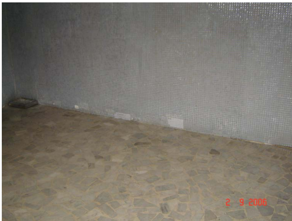
Foto 5.8.1 – Reposição pontual de pastilha de coloração diferente da original.
