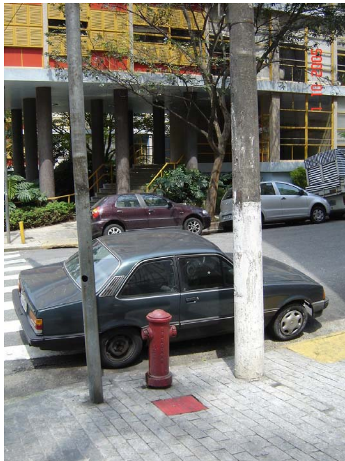
Foto 5.10.8. – Inexistência de sistema de combate a incêndio.
