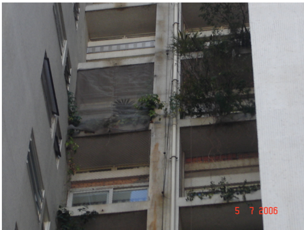
Foto 5.7.13 – Introdução de tela tipo mosquiteira externamente na esquadria do dormitório.
