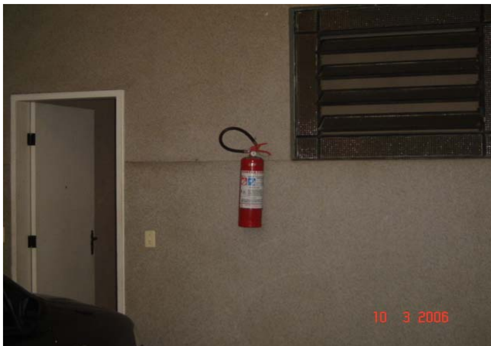
Foto 5.8.1 - Substituição do revestimento original de paredes e pilares.
