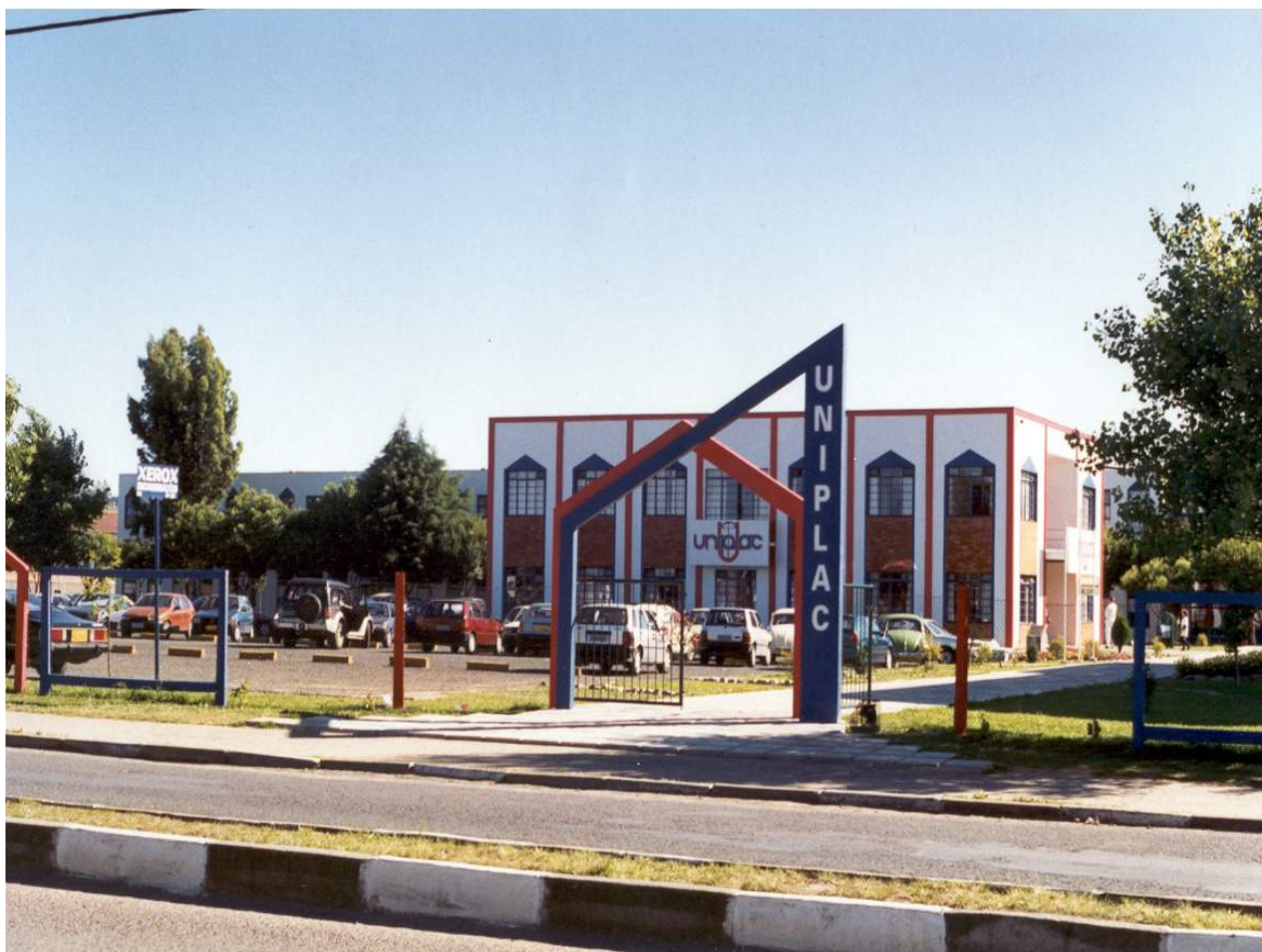
Figura 6 - Foto da UNIPLAC - Lages/SC
