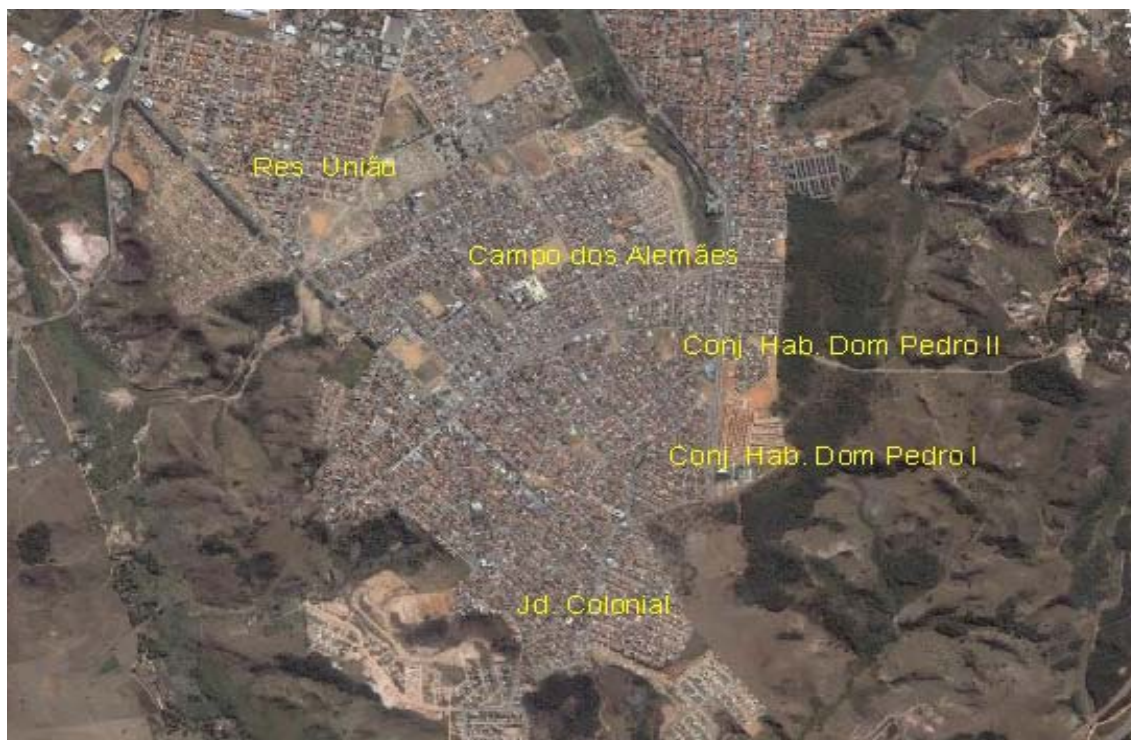
Figura 1.8 - Bairro do Campo dos Alemães e Conjunto Habitacional Dom Pedro I e II Fonte: Google, 2006.
