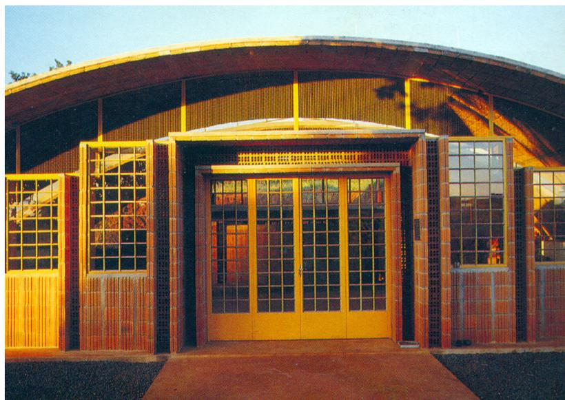
O que diferenciava essa cobertura, de muitas utilizadas para cobrir grandes áreas, era o conforto térmico. Os componentes feitos para abóbadas, devido às duas camadas de ar existentes nos tijolos cerâmicos, quebravam a radiação direta do sol.
