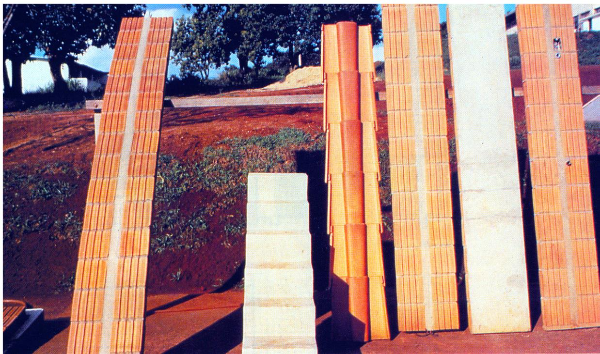
No protótipo da casa explorou-se o uso de peças de parede que, além de servirem para a vedação, tinham a função de pilares de sustentação. Alguns painéis de laje, usados para o forro, serviam como bancada de janela, como banco para a varanda e para o nicho de entrada.
