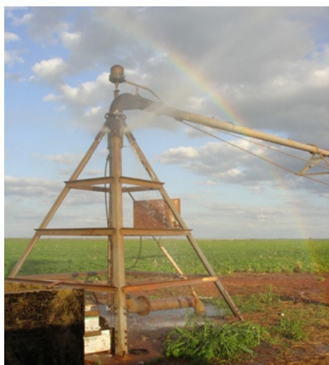
Figura 5.17. – Vazamento no ponto do pivô G13 do Assentamento Itamarati I em abril de 2006
