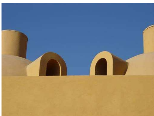
Detalhe da Construção Em El Gouna
