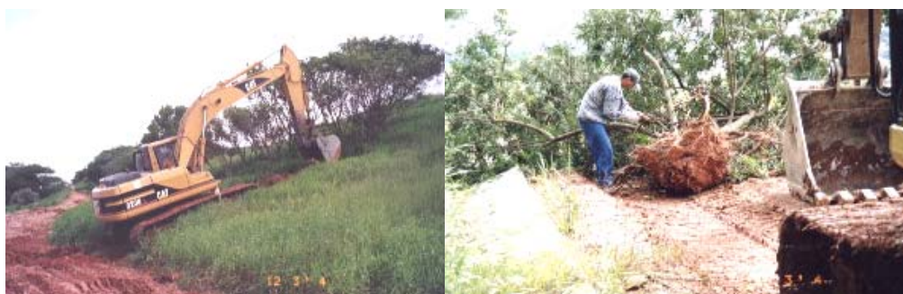
Figura 92 - Abertura de cava e retirada de planta
