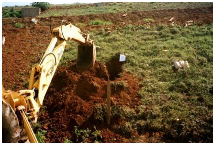
Foto 4 - Abertura de cavas que antecedeu ao plantio
