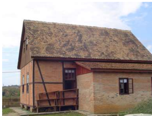
Figs. 70 e 71: Vista da frente e dos fundos da Escola Bucovina, no seu terreno original. Na fotografia à direita, nota-se a reforma feita posteriormente, com técnica diversa da original, o que auxilia na sua distinguibilidade e mesmo na sua reversibilidade.
