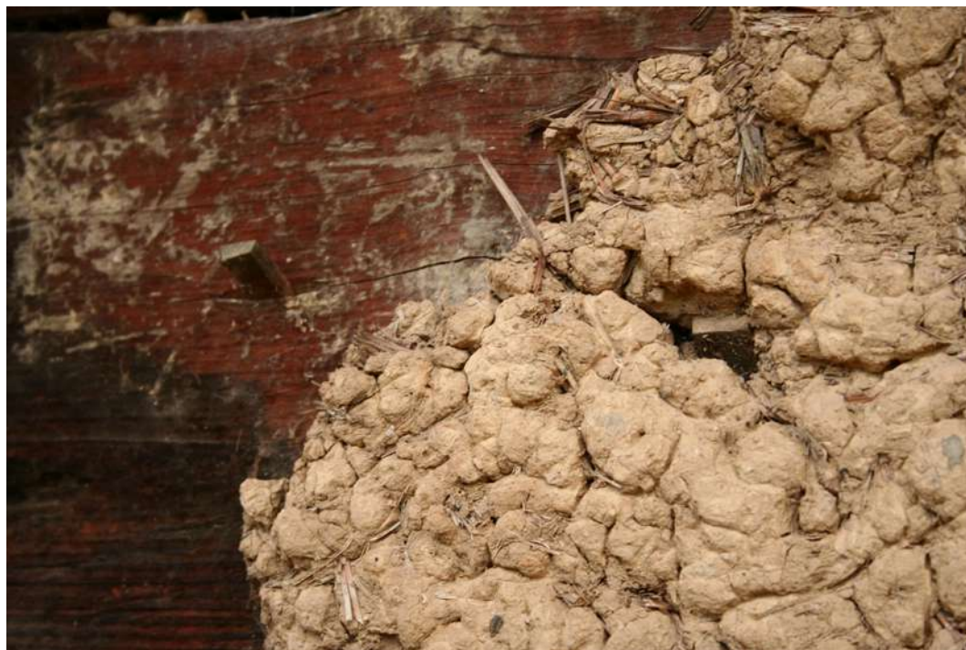
Fig. 105: Vista mais aproximada da argamassa de barro, das pranchas de madeira e das cavilhas.
