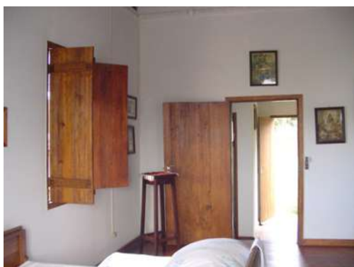
Figs. 72 e 73: Acima à esquerda, vista da sala de aula, totalmente restaurada, com seus móveis originais. O interior da escola era rebocado com argamassa de barro. O assoalho é todo em tábuas de pinheiro.
