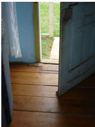
Figs. 92 e 93: Nas duas fotos à esquerda, vemos a parte dos fundos, que foi adicionada. Pela qualidade do assoalho, e pela continuidade da estrutura em enxaimel na lateral, além das mesmas telhas (com o mesmo grau de envelhecimento) podemos deduzir que esta adição não deve ter sido feita muito depois da casa.
