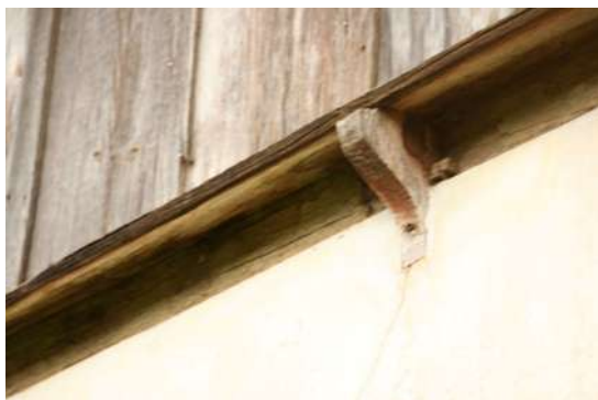
Fig. 95: Novamente, nesta foto, podemos ver um detalhe do apoio de madeira que, embutido na estrutura em enxaimel, sustenta a vedação do sótão.
