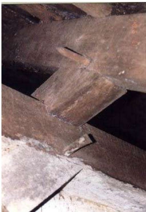
Figs. 46 e 47: Estruturas idênticas de encaixe, com cravos de madeira. À esquerda, o Antigo Curtume, Rio Negro. À direita, a Casa Seidl, em Mafra.
