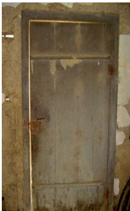
Figs. 62 e 63: acima, croqui esquemático da porta simples, com tábuas encaixadas em macho-fêmea. À direita, fotografia da porta dos fundos da Casa Seidl, com fechadura original.
