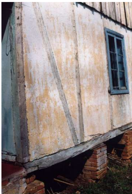
Fig. 43 (à esquerda): Detalhe da estrutura em enxaimel da Casa Lauer (descendentes de alemães, e não de bucovinos). Localizada no Passa Três, Rio Negro.
