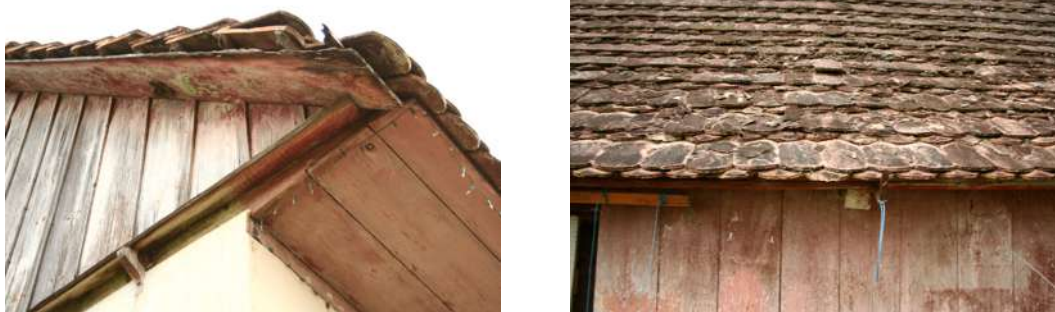
Figs. 99 e 100: Detalhe do beiral e o hábil trabalho com madeira dos imigrantes bucovinos. À direita, as telhas planas usadas em muitas casas. Não se sabe se são originais, mas são muito antigas.
