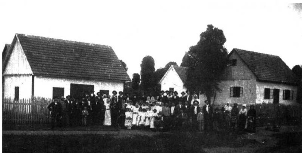
Fig. 83: Foto da residência de Johann Herzer, à direita, com a cozinha separa ao fundo. À esquerda da foto está a ferraria. A aglomeração se dá devido ao casamento de sua filha Rosalia.
