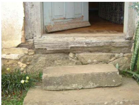
Figs. 90 e 91: Detalhes da fundação: a fundação é parte de alvenaria de pedra (contínua, ao longo do corpo da casa), porém nos fundos, sob a varanda modificada, a fundação é de alvenaria de tijolos. Na foto à esquerda, vemos a entrada principal da casa. A fundação, ali, é de alvenaria de pedras, sob a qual se apóia o baldrame do sistema enxaimel. Pedras soltas fazem as vezes de degraus.
