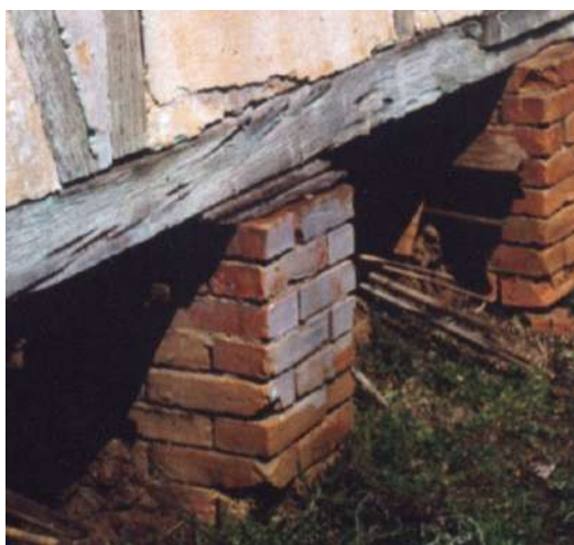
Fig. 54 (acima): embasamento pontual com tijolos, consistência enxaimel de alvenaria com vedação, casa Lauer. Rio Negro.
