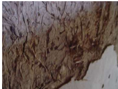
Figs. 111 e 112: Acima, a Casa Seidl atualmente, durante o pôr do sol. À direita, detalhe do revestimento em argamassa de barro.
