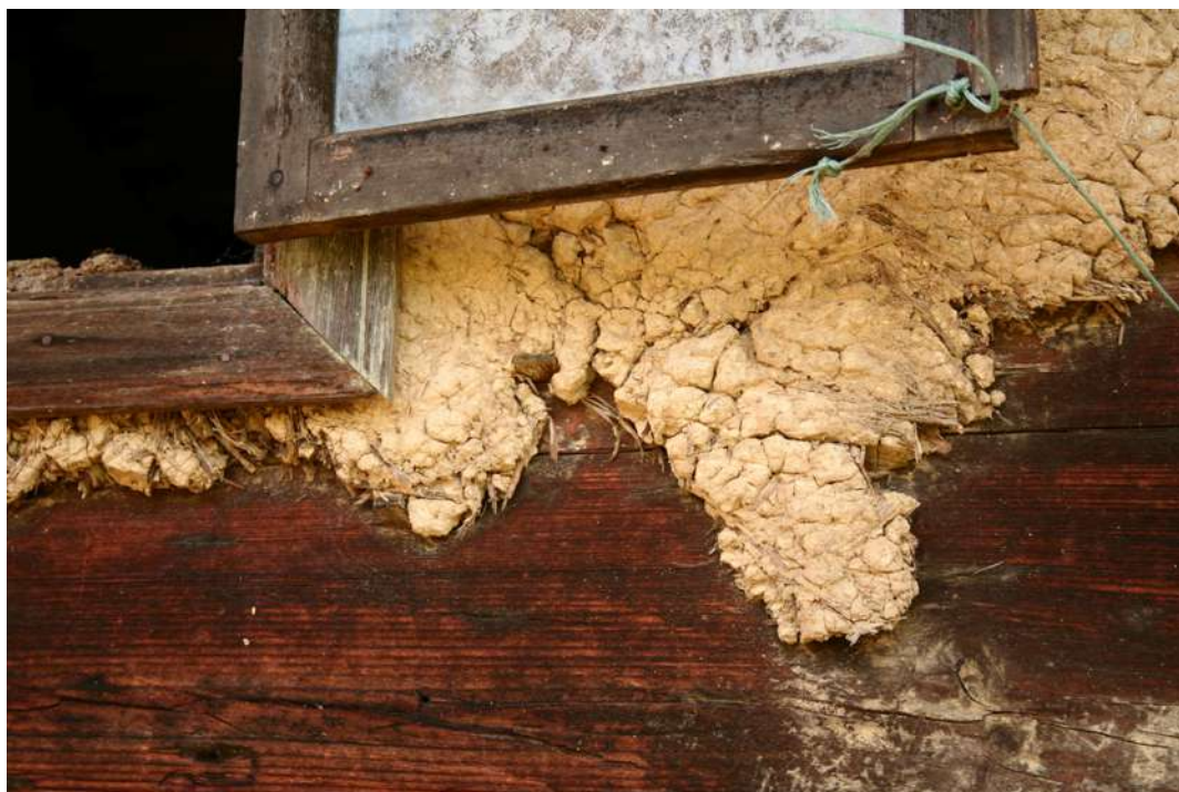
Fig. 104: Vista aproximada das paredes externas da casa. Nota-se que o barro vêm se descolando das pranchas maciças de madeira, que se conservam intactas. É possível observar as cavilhas cravadas na madeira.
