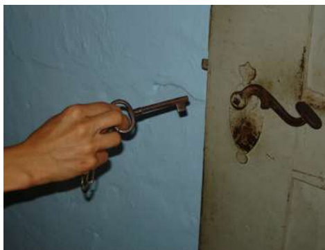
Figs. 85 e 86: Chave e fechadura original na Casa Herzer. Esta é a fechadura hamburguesa .
