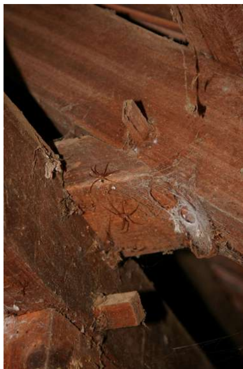
Figs. 46 e 47: Estruturas idênticas de encaixe, com cravos de madeira. À esquerda, o Antigo Curtume, Rio Negro. À direita, a Casa Seidl, em Mafra.
