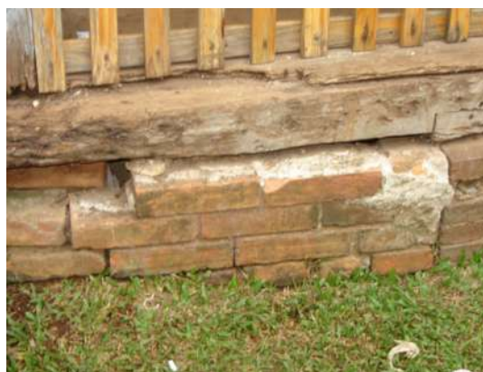
Figs. 90 e 91: Detalhes da fundação: a fundação é parte de alvenaria de pedra (contínua, ao longo do corpo da casa), porém nos fundos, sob a varanda modificada, a fundação é de alvenaria de tijolos. Na foto à esquerda, vemos a entrada principal da casa. A fundação, ali, é de alvenaria de pedras, sob a qual se apóia o baldrame do sistema enxaimel. Pedras soltas fazem as vezes de degraus.
