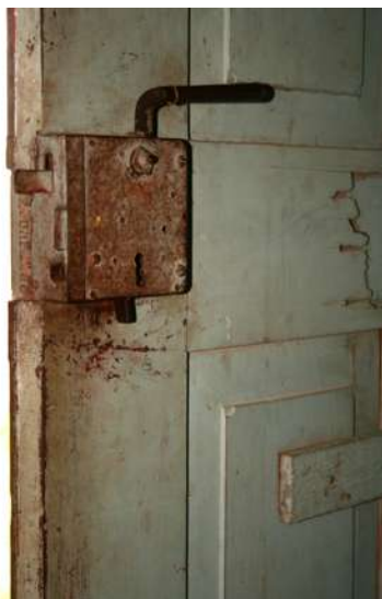
Figs. 85 e 86: Chave e fechadura original na Casa Herzer. Esta é a fechadura hamburguesa .
