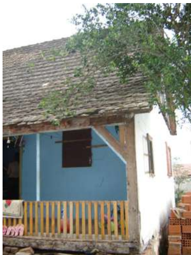
Figs. 92 e 93: Nas duas fotos à esquerda, vemos a parte dos fundos, que foi adicionada. Pela qualidade do assoalho, e pela continuidade da estrutura em enxaimel na lateral, além das mesmas telhas (com o mesmo grau de envelhecimento) podemos deduzir que esta adição não deve ter sido feita muito depois da casa.
