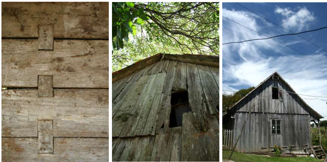
Fig. 115: À esquerda, detalhe do encaixe dos troncos em blocausse.
