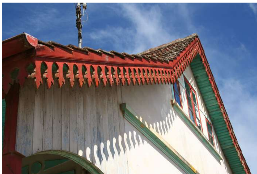
Fig. 34: Casa Becker, que não será analisada neste capítulo devido às poucas informações obtidas a respeito da casa e de seus construtores.
