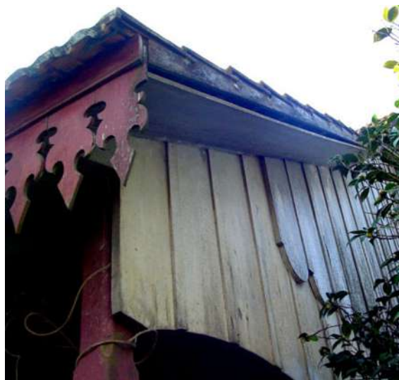
Figs: 125: Fotografia dos detalhes da casa Sprotz, como o lambrequim ornando o beiral, e o trabalho de marcenaria no recorte das tábuas das paredes.
