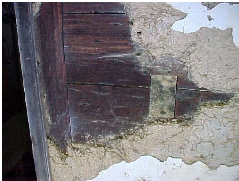
Fig. 103: Nesta foto, podemos ver um detalhe dos troncos encaixados e o revestimento de argamassa de argila com palha de trigo. Também é possível ver o acabamento liso, pintado com cal fina.
