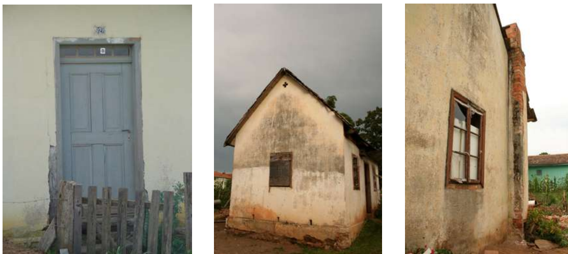
Fig. 96: À direita, detalhe da porta principal, com bandeira de vidro na parte superior.
