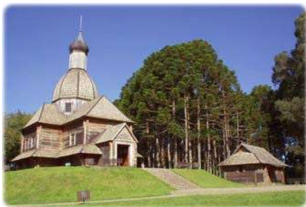
Fig. 53: Memorial Ucraniano, em Curitiba, PR. As construções também são todas em madeira, com destaque para as telhas feitas com lascas de pinheiro.
