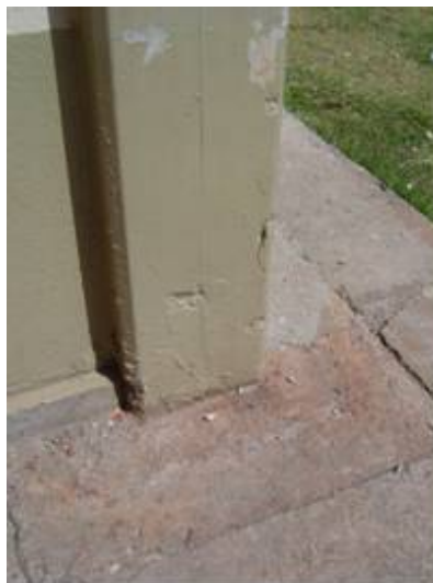
Figura 40 [Pc 3.7] – Desprendimento do concreto de cobertura da armadura na base de alguns pilares.
