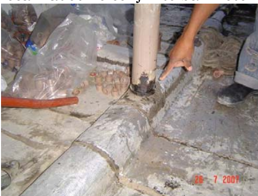
Figura 63 [Pc 9.4] – Tubos condutores de águas pluviais rompidos e degradados, com as presilhas soltas ou quebradas.
