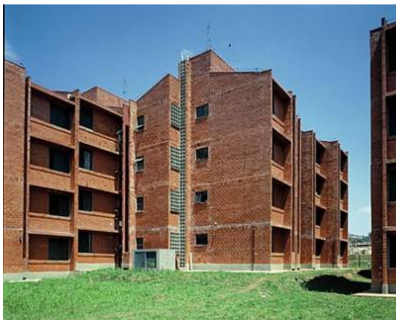
Figura 20: Vista externa de blocos de apartamentos do conjunto – arquivo USINA. Fonte: http://www.usinactah.org.br/ – Álbum de fotografias.
