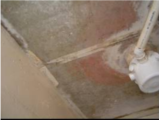
Figura 35 [Pc 3.2] – Alteração da modulação de placas de fechamento e inexistência de tratamento de junta na face inferior das lajes.
