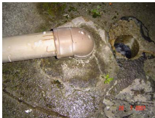
Figura 63 [Pc 9.4] – Tubos condutores de águas pluviais rompidos e degradados, com as presilhas soltas ou quebradas.
