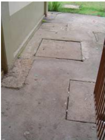
Figura 32 [Pc 2.1] – Blocos de fundação sobre as estacas pré-moldadas com cota de arrasamento superior a do piso acabado.
