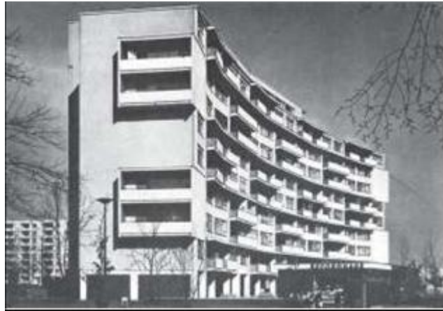
Figura 4: Vista principal do bloco de Interbau Hansaviertel em Berlim, 1956. Arquitetos Walter Gropius e N. Fletcher. Fonte: BERDINI, 1996, p. 224.
