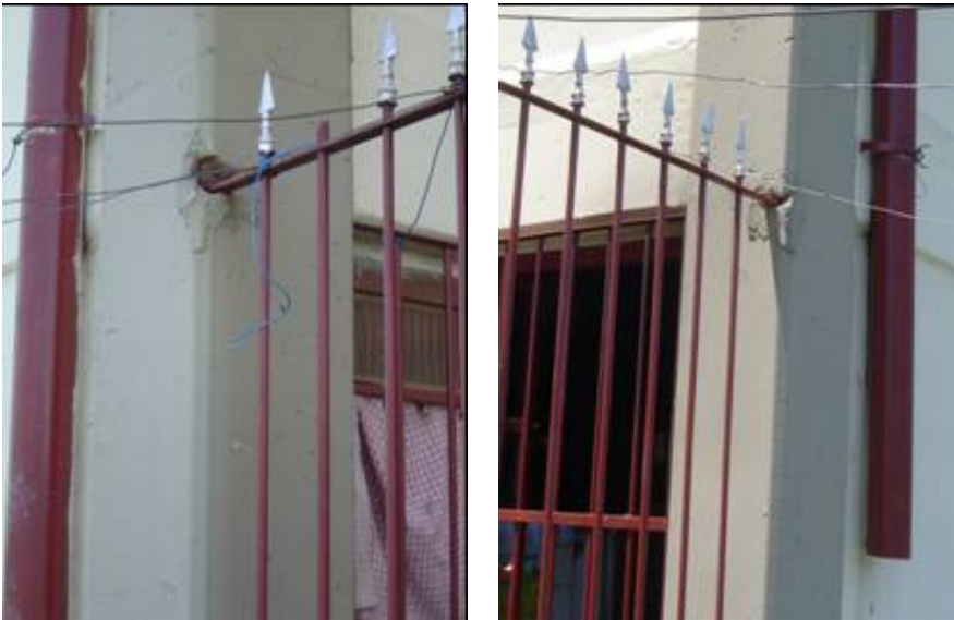
Figura 38 [Pc 3.5] – Fixação imprópria de portões e grades de fechamento, no pavimento térreo, na armadura da estrutura do pilar.
