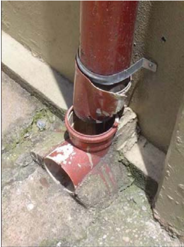
Figura 62 [Pc 9.3] – Tubos condutores de águas pluviais rompidos e degradados, com as presilhas soltas ou quebradas.
