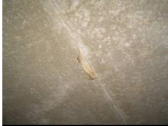
Figura 35 [Pc 3.2] – Alteração da modulação de placas de fechamento e inexistência de tratamento de junta na face inferior das lajes.
