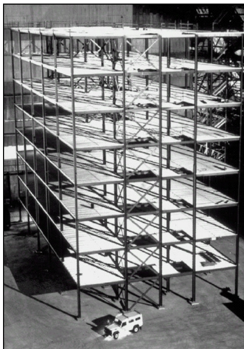
Figura 2.4.1 Edifício com elementos estruturais de aço e mistos ensaiado em Cardington, UK (Lawson, 2001).
