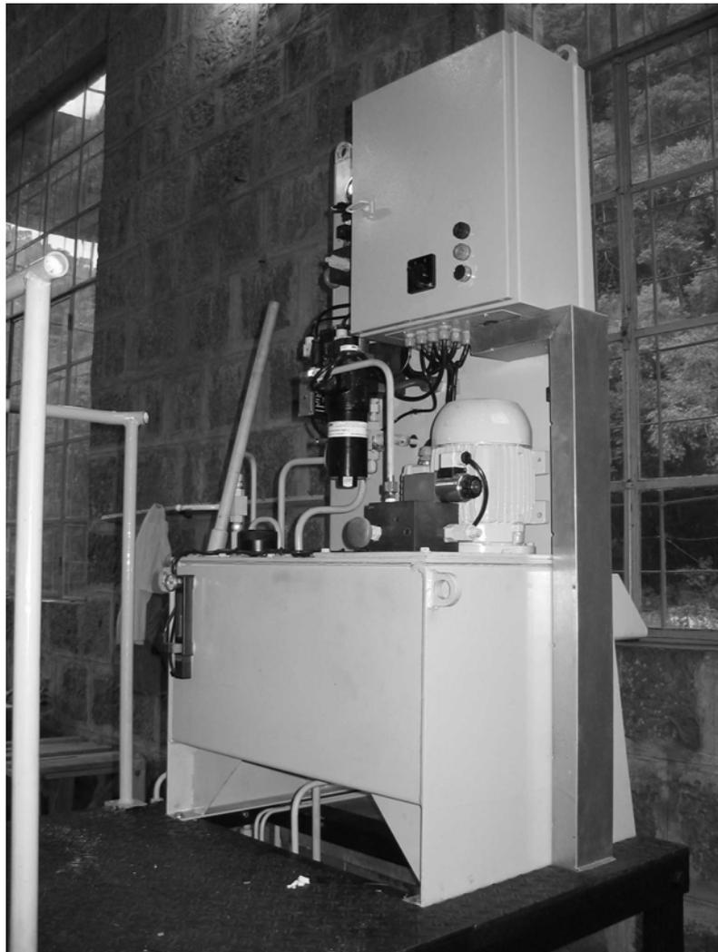
Figura 1.2 – Unidade de potencia hidráulica utilizada em uma central hidroelétrica.
