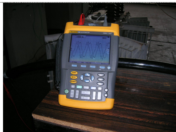
Figura 6.35 – Detalhe de uma medição de corrente de fuga e tensão aplicada.
