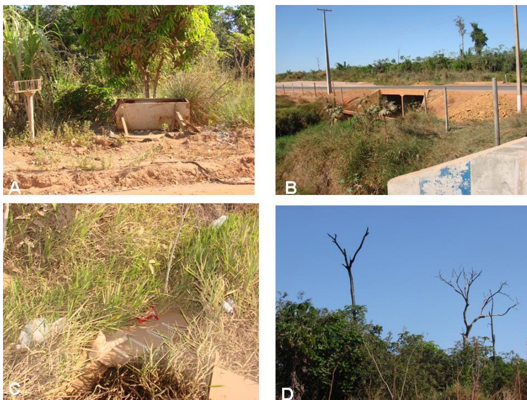
FIGURA 27 – OCORRÊNCIAS NA RESERVA R7. (A,C) DEPÓSITO DE RESÍDUOS SÓLIDOS, (B) PONTE CONSTRUÍDA PARA ABERTURA DA RUA, (D) TRONCOS DE ÁRVORES QUEIMADAS EM INCÊNDIO EM 2003. FONTE: KUNTZ (2008)
