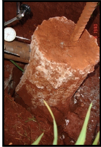
Figura 5.5 - Deslocamento do solo durante prova de carga da estaca S3
