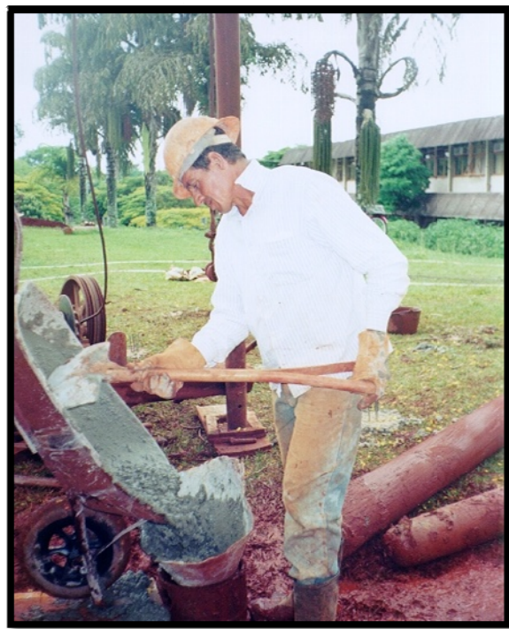
Figura 2.21 - Concretagem da estaca
