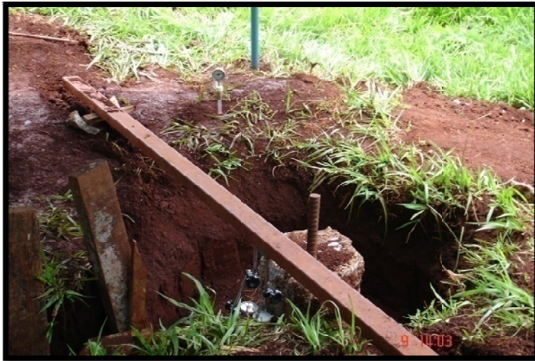
Figura 5.7 - Estaca S6 e tensiômetro instalado
