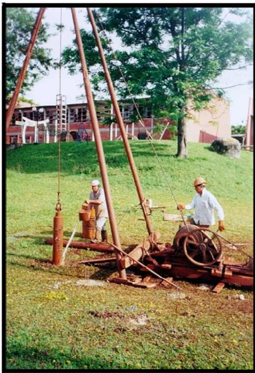
Figura 2.18 - Escavação com pilão
