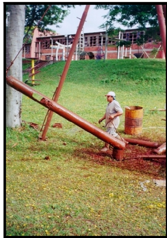
Figura 2.19 - Escavação com piteira
