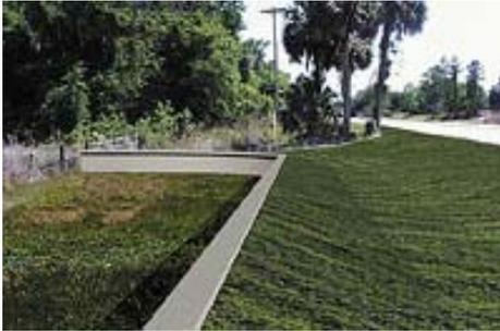
**Foto 49:** Estrutura para impedir passagem de anfíbios e répteis
