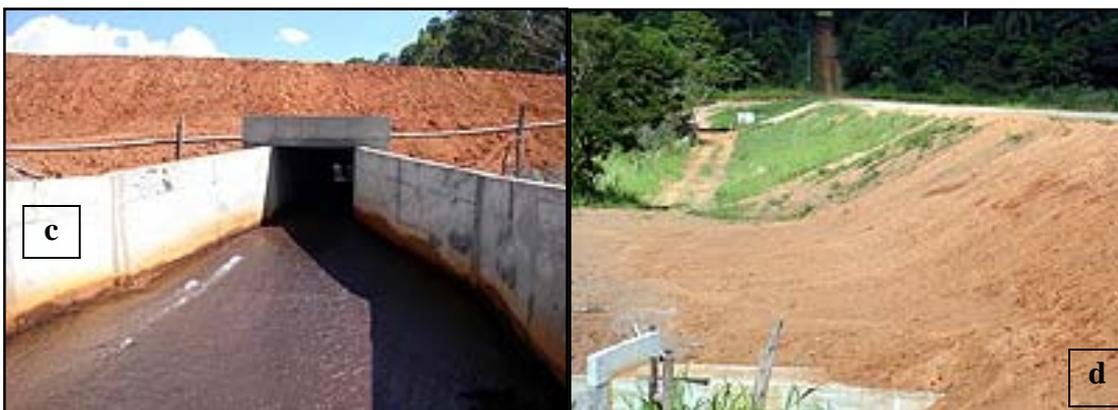
FIGURA 21c. Canal de escoamento da represa.
