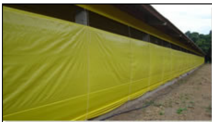
Foto 12 - Produto da indústria têxtil do Oeste Catarinense. As cortinas são utilizadas na climatização das instalações para criação de suínos e aves. Na foto, exemplo de uso de cortinas em aviário. Fonte: Têxtil Oeste (2007).
