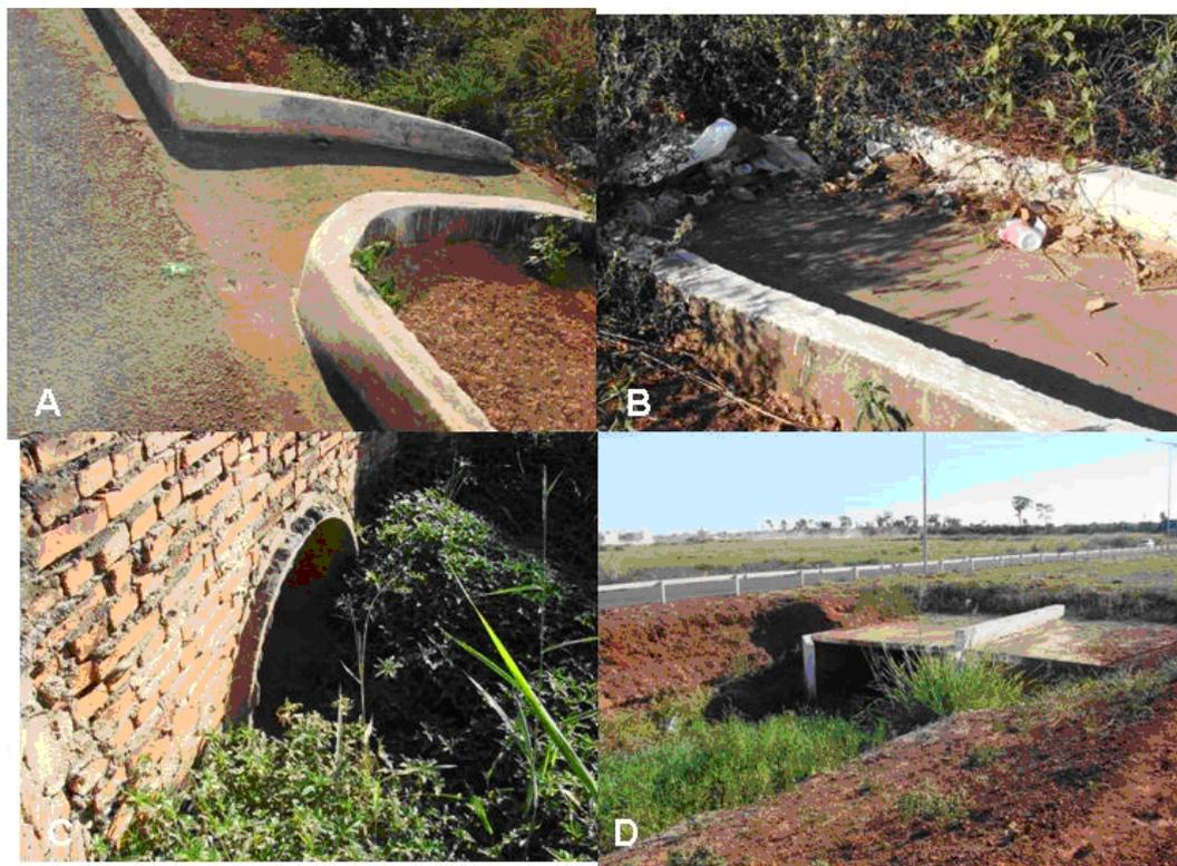
FIGURA 25 – (A, B) CAPTAÇÃO DE ÁGUAS FLUVIAIS; (C, D) TUBULAÇÃO DE DRENAGEM
