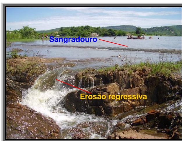
Figura 70. Erosão regressiva no sangradouro.
