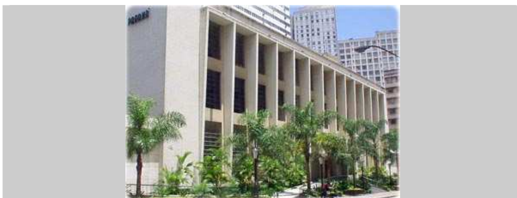
Figura 18 – Vista da Biblioteca Pública do Paraná Fonte: GUIA GEOGRÁFICO (2007)
