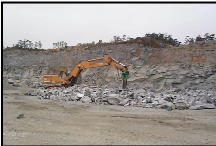
Figura 2.11 – Desmonte secundário por rompedor secundário (CUCHIERATO, 2000).
