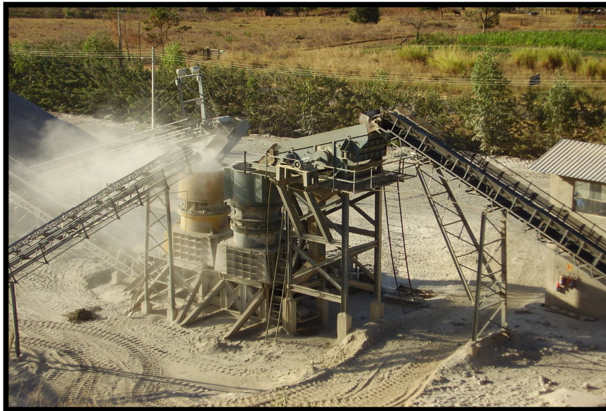
Figura 2.13 – Britadores da planta de britagem - Britagran.
