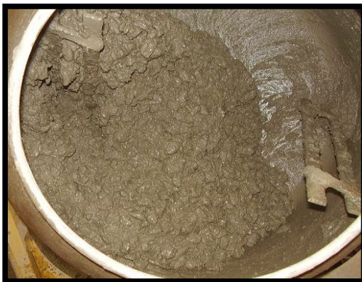
Figura 4.15 – Preparação de concreto na betoneira.
