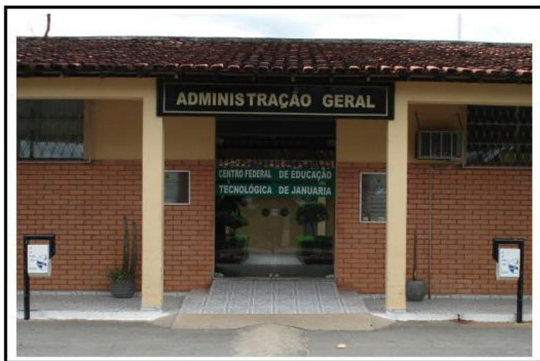
Figura 2: Prédio da Administração Geral do CEFET de Januária
