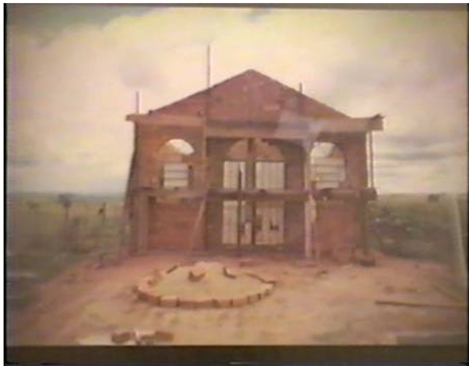
(fachada do Templo na etapa final da construção)
