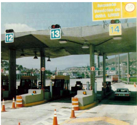
Fig 3.5.m – cobrança automática – Ponte Rio- Niterói
