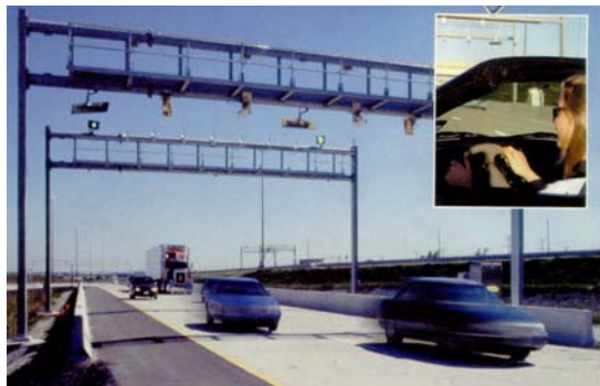
Fig 3.5.n – DSRC – cobrança de tarifa
