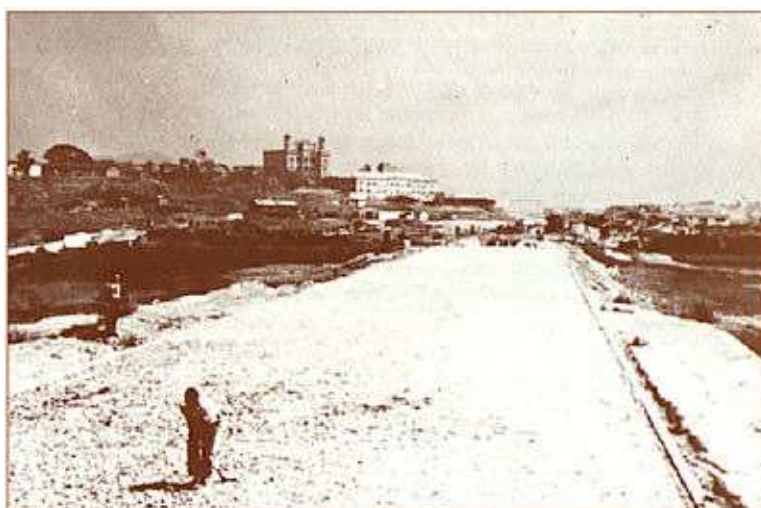
Figura 1: Obra de construção da Av. Brasil, trecho Manguinhos. s/autor. c. 1940. Acervo do Arquivo Geral da Cidade.
