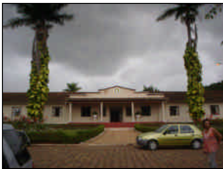
Fachada dos prédios
