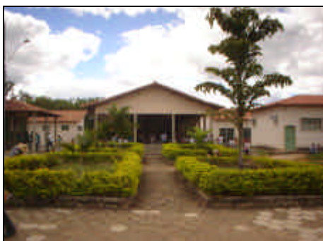
Fachada dos prédios
