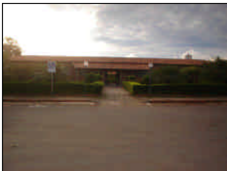
Fachada dos prédios
