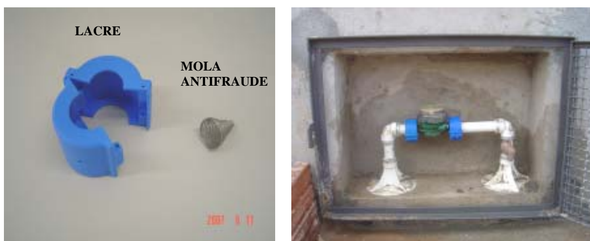
Figura 17 – Fotografia de lacre, antifraude para hidrômetro e cavalete padrão lacrado.
