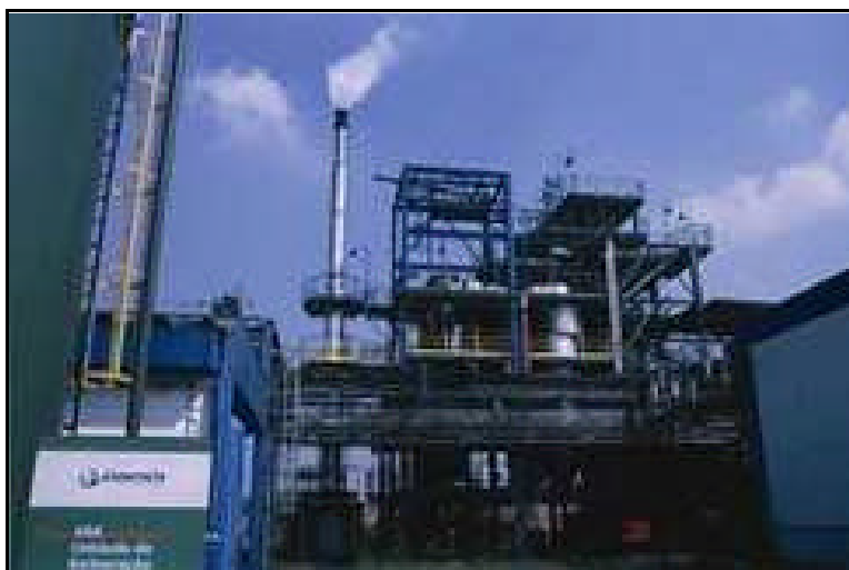
Figura 3.2: Incinerador da Essencis, (Fonte: site da Essencis)
