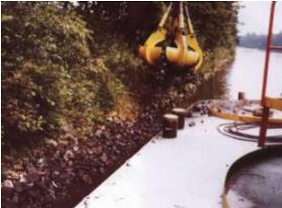
**Figura 30** - Contenção em margem de rios (Alemanha)
