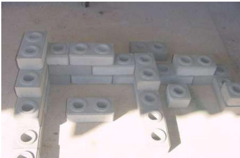
**Figura 72** - A amarração da montagem dos blocos
