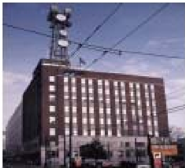
Figura 3.5 – Telus Office Building, antes da reforma.
