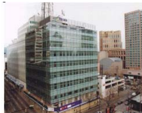
Figura 3.6 – Telus Office Building, após a reforma.
