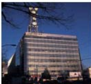
Figura 3.7 – Telus Office Building, após a reforma.
