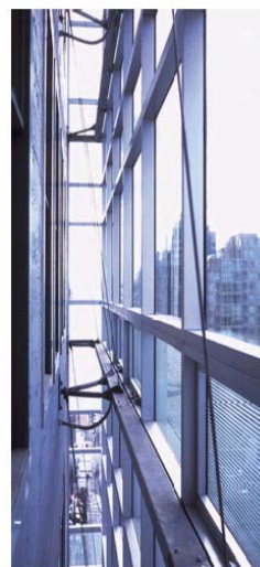
Figura 3.8 – Intervalo para a circulação de ar quente, utilizado durante o inverno. No verão proporciona sombra, e atua como uma abertura plena de ar nas estações
