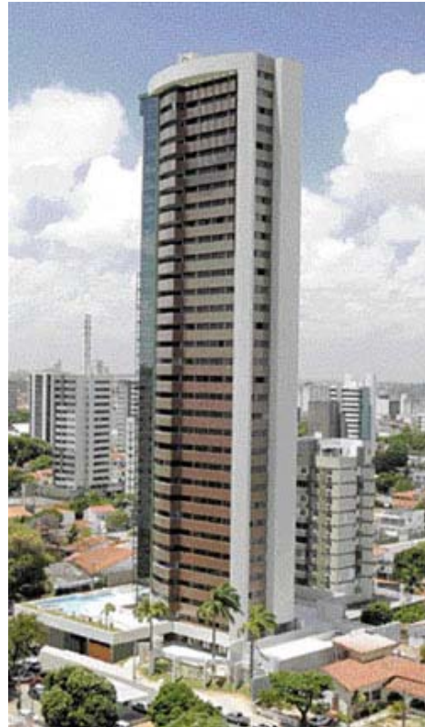
Figura 6.2 – Vista em perspectiva do edifício em estudo
