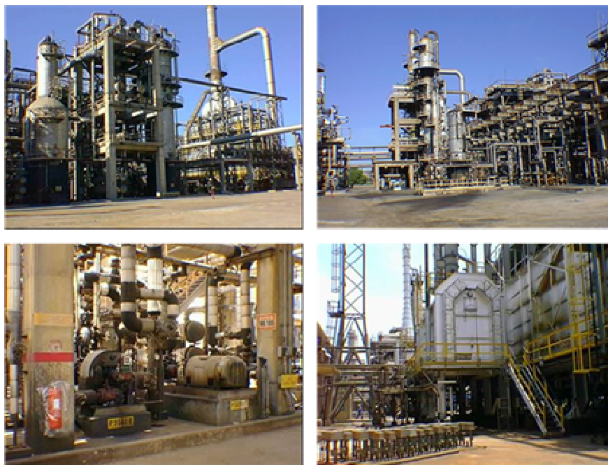
Figura 9: Vista da U-1520 Fonte: REDUC (2004)
