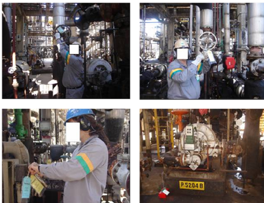
Figura 16: Realização do Isolamento, Etiquetagem e Eliminação das Energias Residuais Fonte: REDUC (2008)
