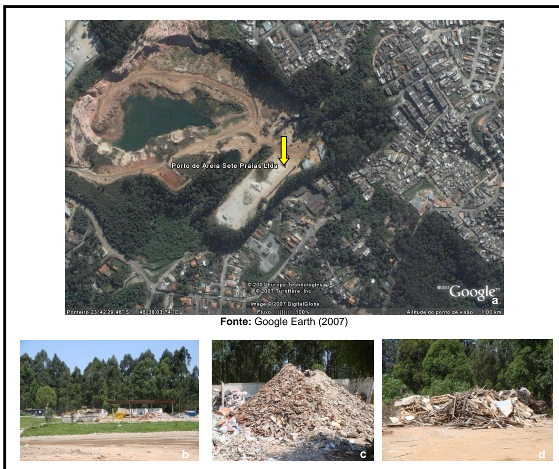
Figura 10 – ATT Sete Praias: a) foto aérea da localização; b) entrada da unidade; c) entulho recebido a espera de triagem; d) madeira triada
