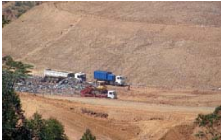
Figura 51 – CTR Epron (Caieiras) Fonte: Santini (2007)
