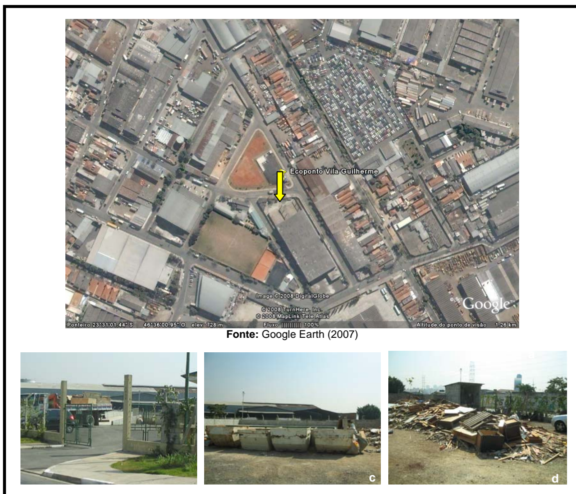
Figura 40 – Ecoponto Vila Guilherme: a) foto aérea da localização; b) entrada da unidade; c) caçambas para recebimento do entulho; d) baias para recebimento de inservíveis
