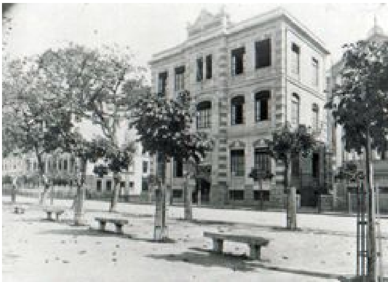
Foto 57 Prédio da Escola Deodoro 124 - sem data; sem autoria
