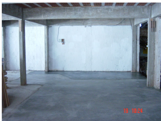
Figura 4.14 - Vista frontal Galpão 1: após a limpeza.
