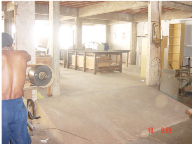
Figura 4.16 – Vista lateral esquerda do Galpao 1: sem os restos de madeira após a arrumação
