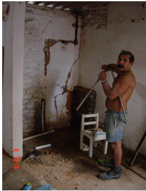
Figura 4.3 - Fase inicial de construção do refeitório da empresa “A”
