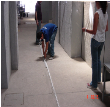
Figura 4.69 - Demarcação da área a ser pintada para estocagem dos armários
