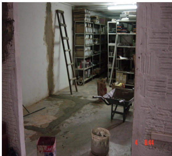
Figura 4.48 – Retirada das paredes para constituição de um único espaço no almoxarifado 1
