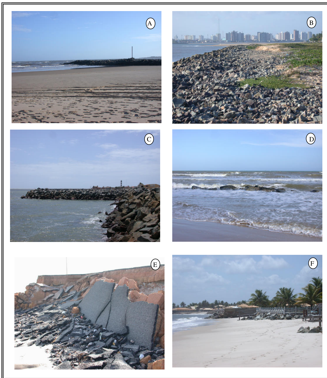
Figura 11 – Ilustração de atuações antrópicas, presente ao longo da área de estudo: (A e B) molhe construído na margem esquerda do rio Sergipe; (C) linha de costa totalmente revestida com obras de contenção (espigões), na margem direita do rio Sergipe; (D) muro de contenção, destruído, na margem esquerda do rio Vaza Barris; (E) rodovia José Sarney parcialmente destruída na margem esquerda do Vaza Barris, a qual encontrava-se na retaguarda do muro de contenção; e (F) linha de costa com obras de contenção na margem esquerda da desembocadura dos rios Piauí/Real
