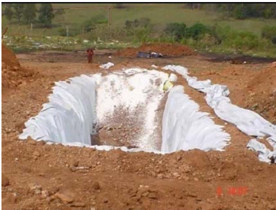
Foto: 31: Vala de resíduos sólidos de serviços de saúde no Distrito Industrial Fonte: Ferreira (2007)
