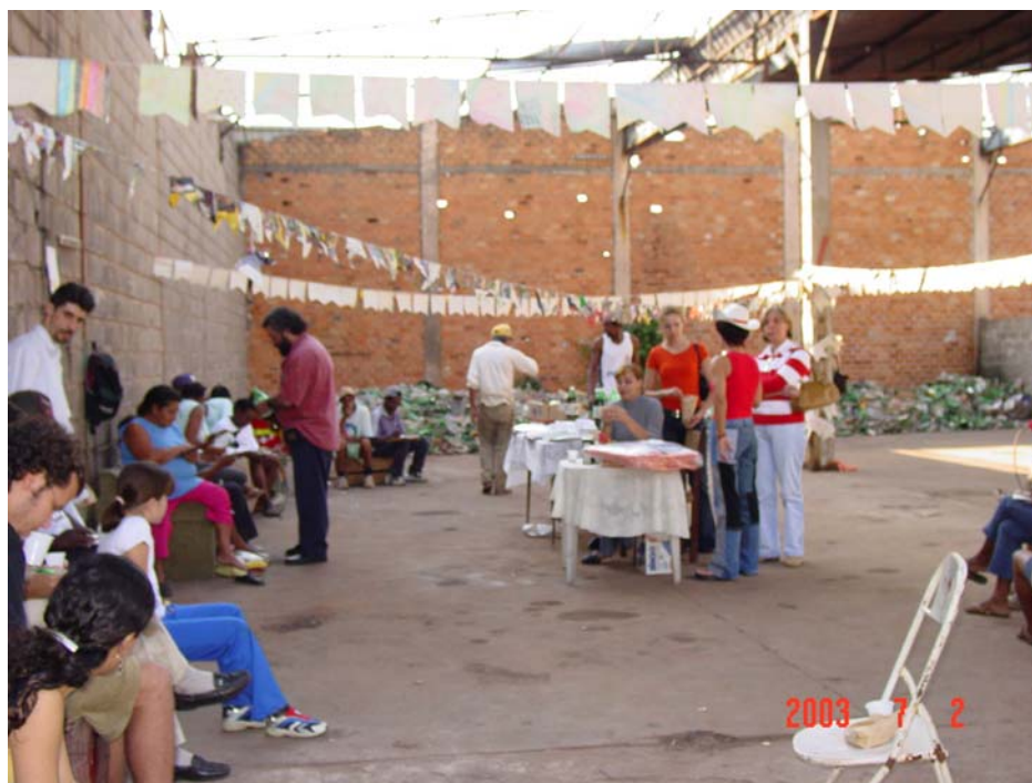
Foto 38 – Estrutura abandonada utilizada pelos cooperados para separação e armazenagem dos materiais coletados (julho/2003)
