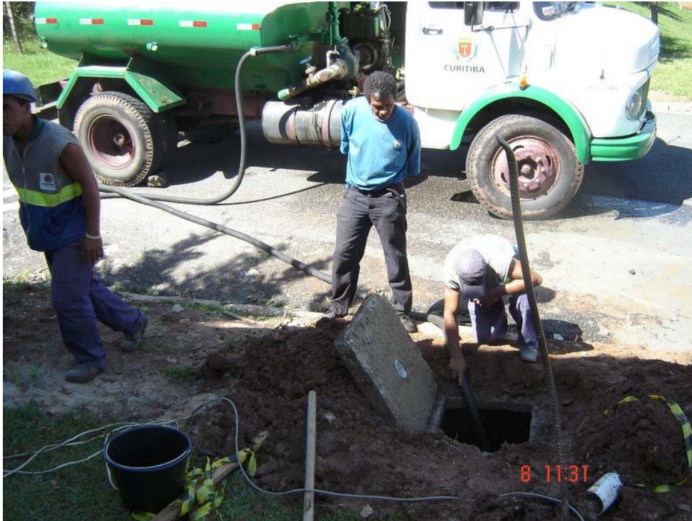
FIGURA 28 – ENCHIMENTO DO SRI COM ÁGUA DO CAMINHÃO PIPA
