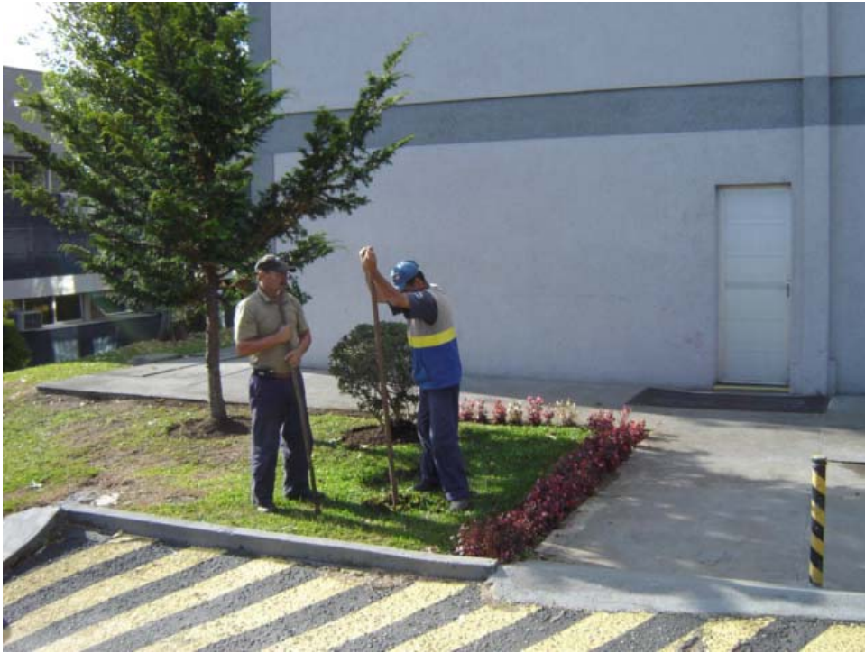
FIGURA 9 - ESCAVAÇÃO DE COVA CILÍNDRICA A TRADO
