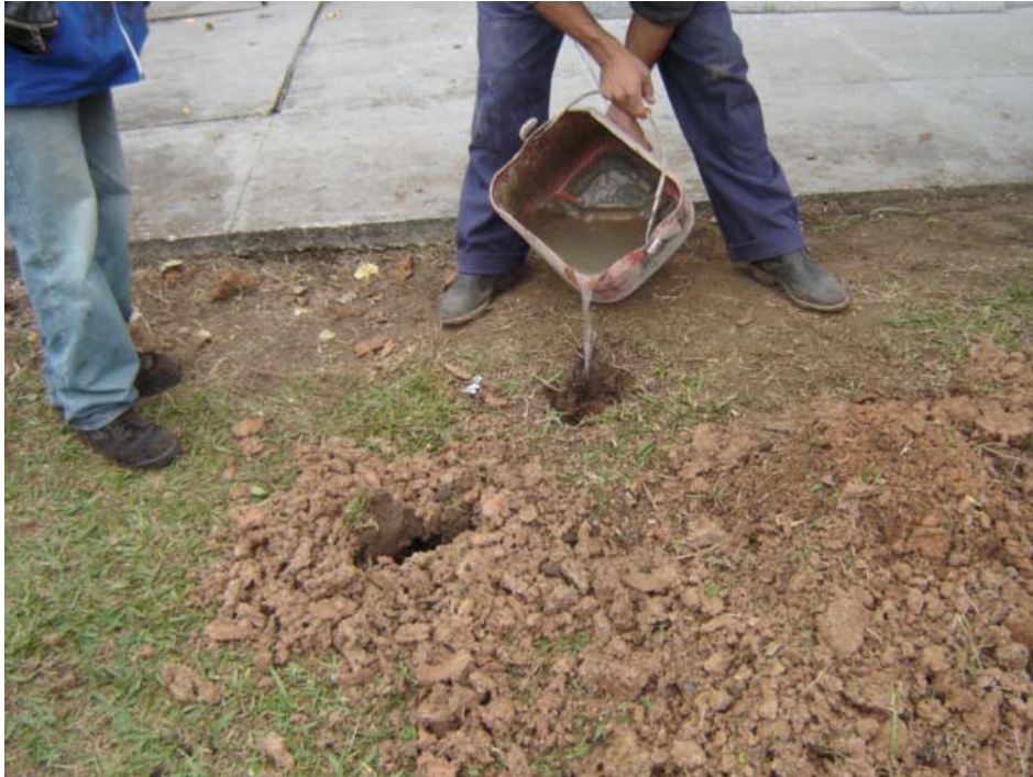
FIGURA 10 - PREENCHIMENTO DAS COVAS CILÍNDRICAS COM ÁGUA
