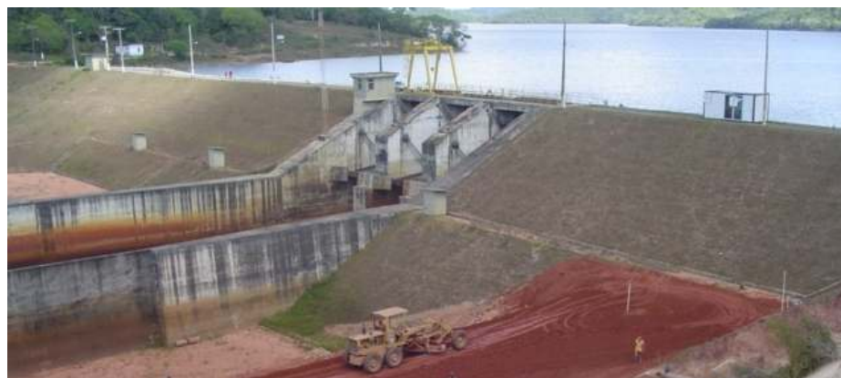
Figura 22 – Vista da Barragem de Santa Helena com detalhe para os maciços de terra e o extravasador em concreto
