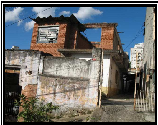
Foto 12 - Casa em processo inicial de demolição na Rua Fidalga.
