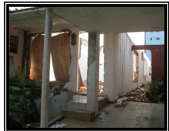
Foto 13 - Casa em processo avançado de demolição, também na Rua Fidalga.
