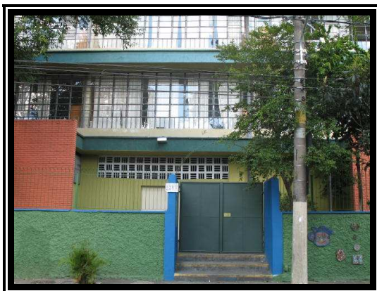
Foto 4 - Fachada da Escola Municipal.
