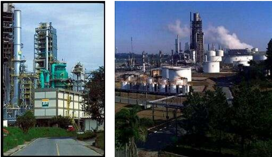
Figura IV-2 - Imagens da Refinaria de Capuava (RECAP) da PETROBRAS.
