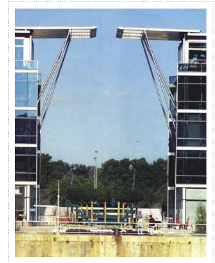
Figura 167. Vazio entre as edificações.
