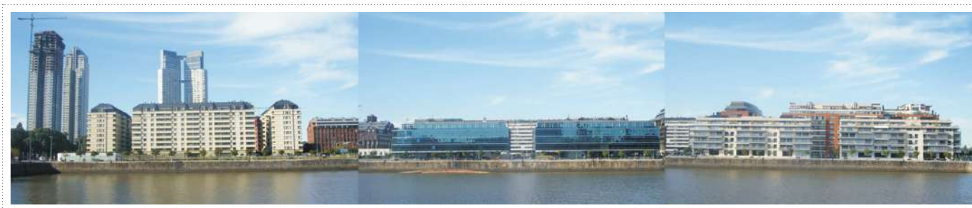
Figura 165. Imagens da situação atual da margem leste do Dique 3.
