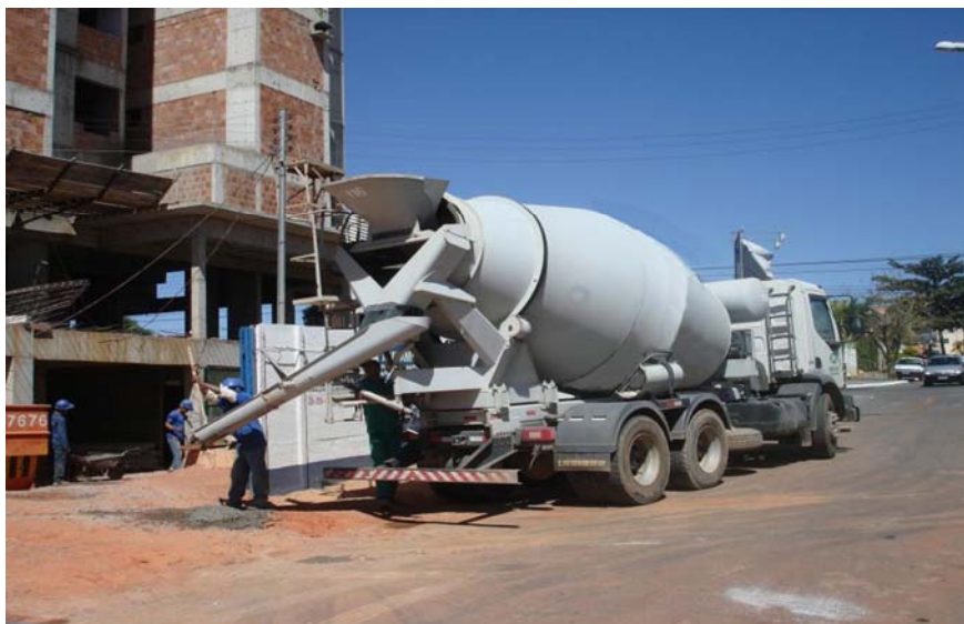
FIGURA 4.3. – Chegada do caminhão à obra.
