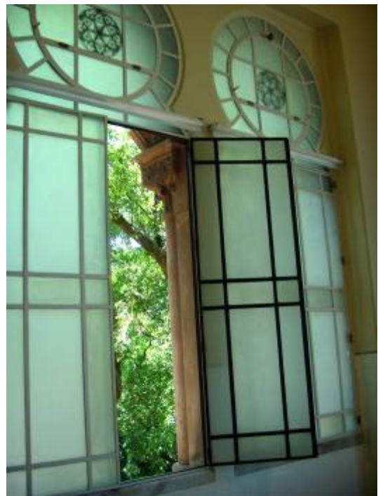
Figura 3. Janelas de sala no 1º pavimento
