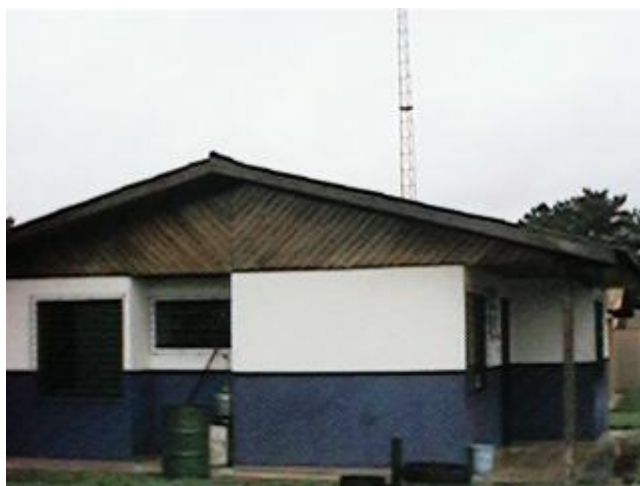
FOTO 24 – VISTA DO POSTO POLICIAL ONDE FOI INSTALADA A ESTAÇÃO DE CONTROLE FONTE: Autoria própria (2004)
