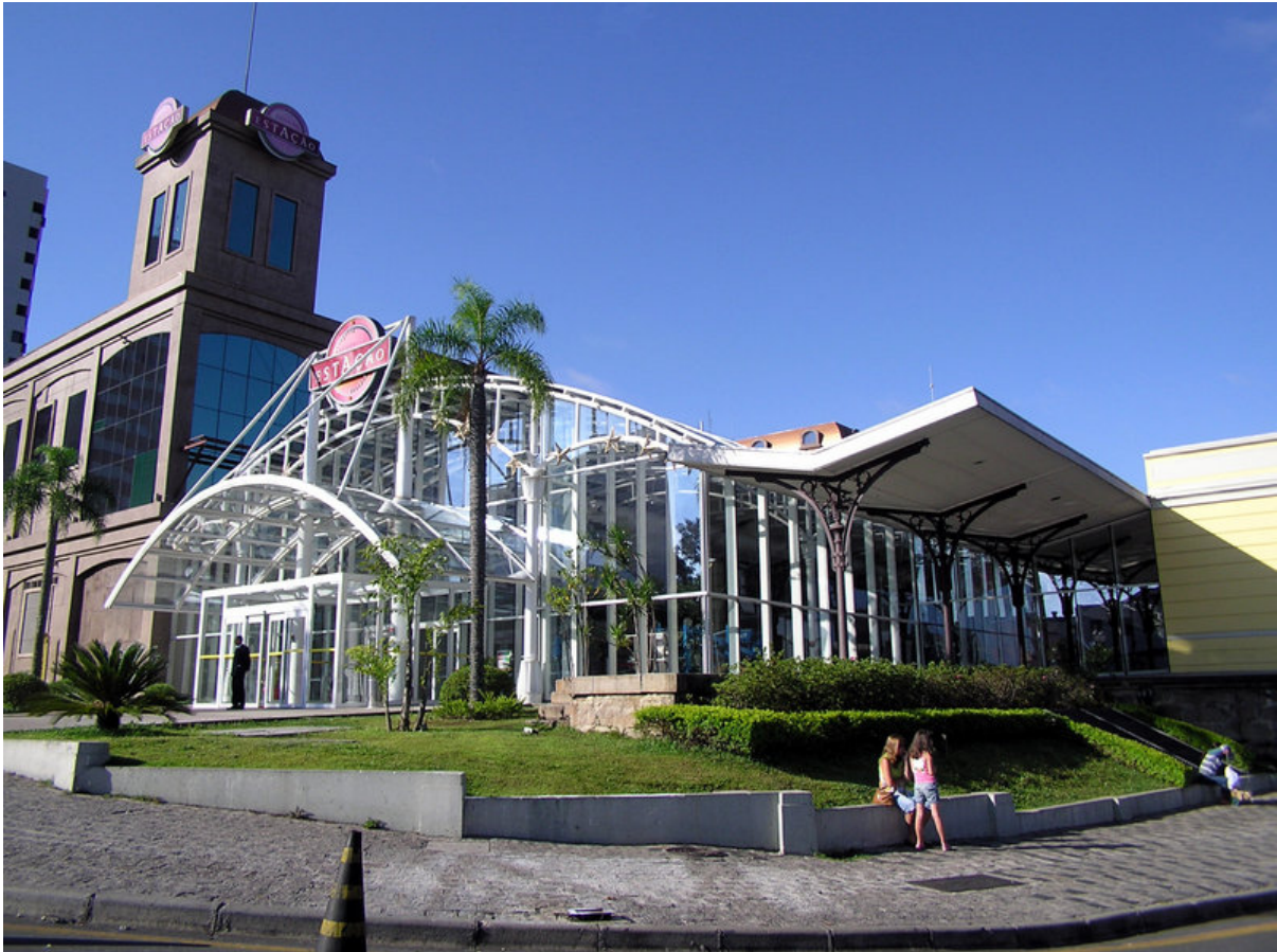
Figura 8 – Foto da reconversão de uso da antiga estação ferroviária para o Shopping Estação
