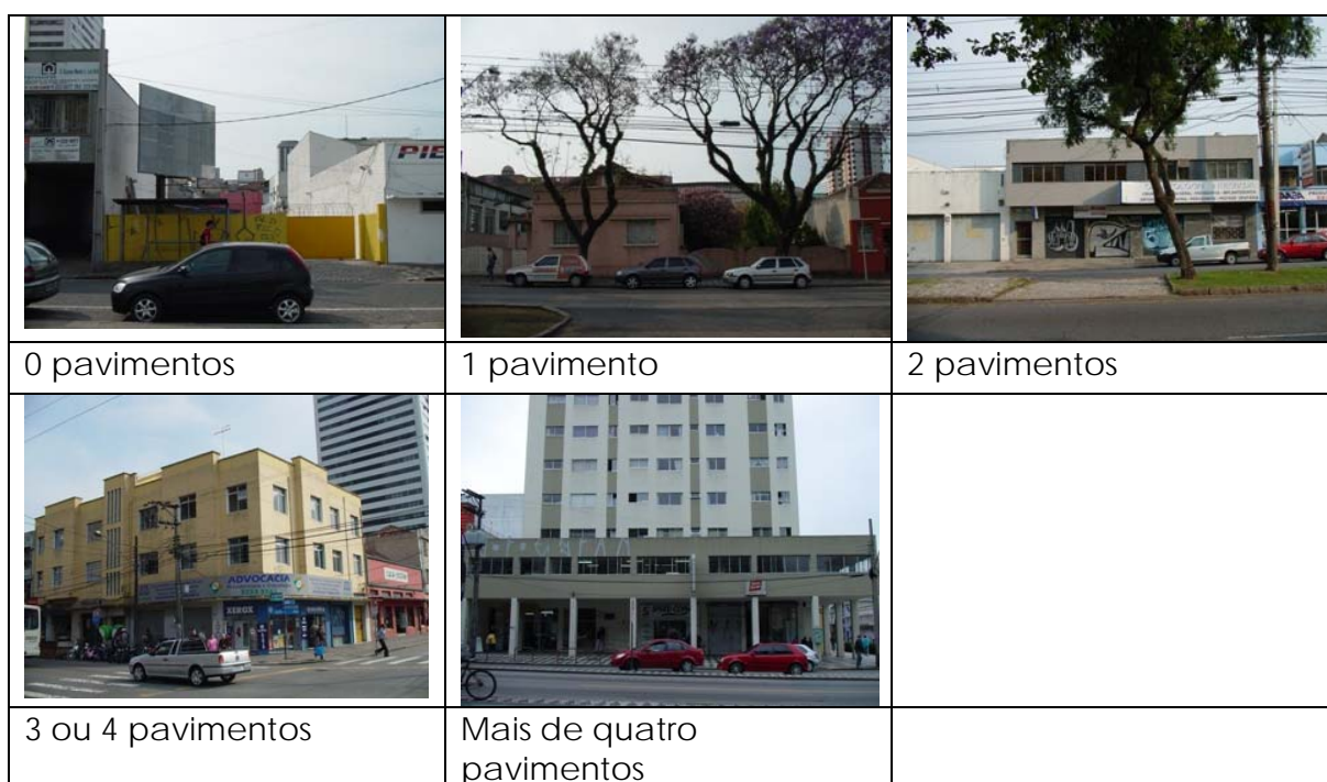
Figura 27 – Fotos das tipologias arquitetônicas analisadas conforme classificação em quantidade de pavimentos
