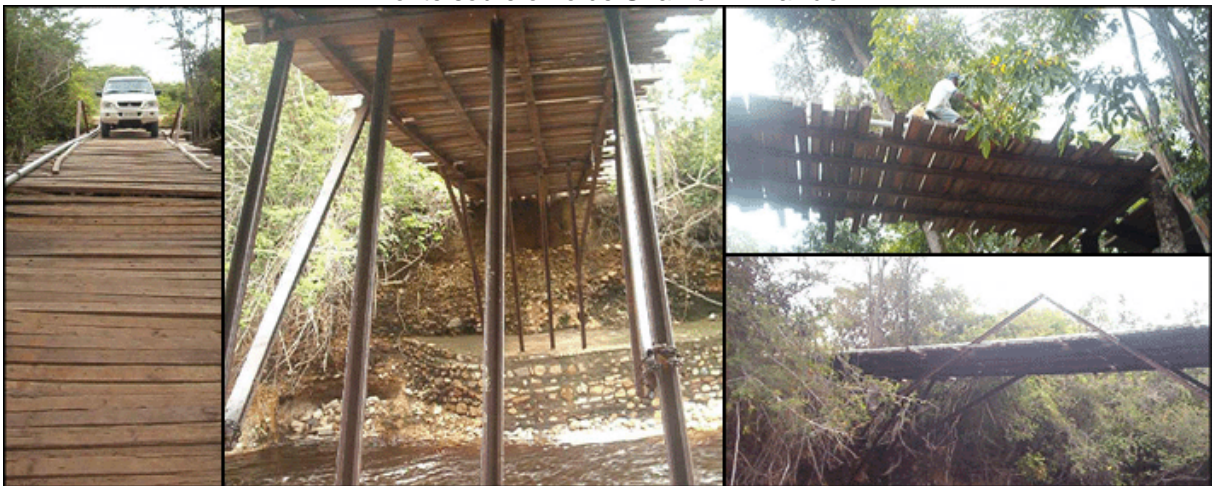
Figura 5.4 Ponte sobre o rio de Una no PA Baixão
