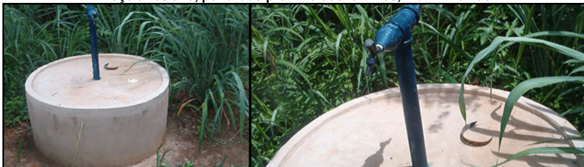
Figura 5.12 Poço artesiano, perfurado próximo aos lotinhos, no PA Baixão
