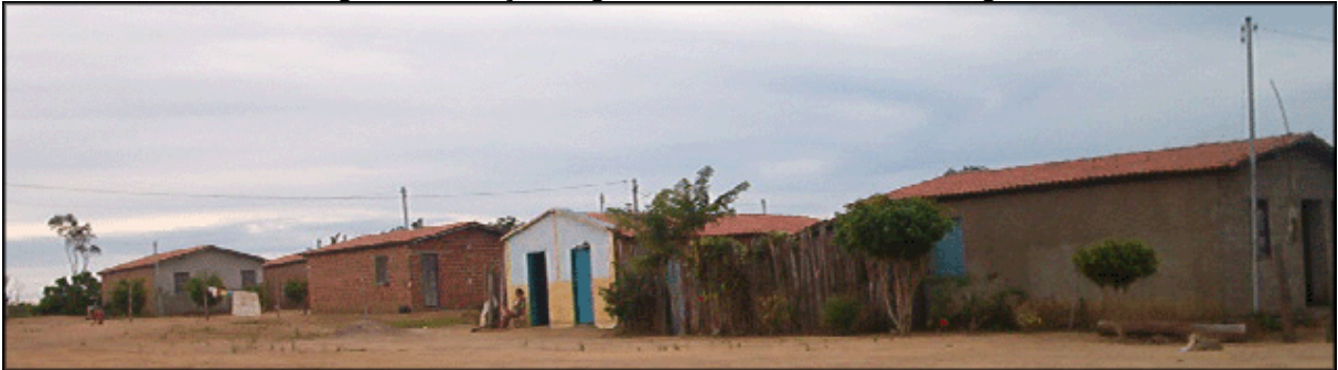
Figura 5.28 Vista da agrovila de Poço Longe, visualizando a rede de energia elétrica.
