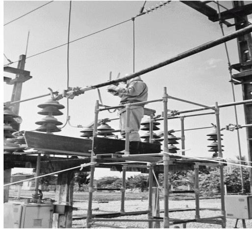
Figura 4. Manutenção em barramento de uma subestação de 69KV.
