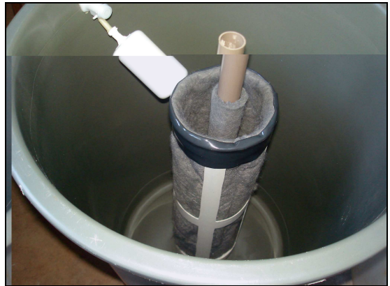
Figura 4.17 – Reservatório de 100L com a coluna instalada.
