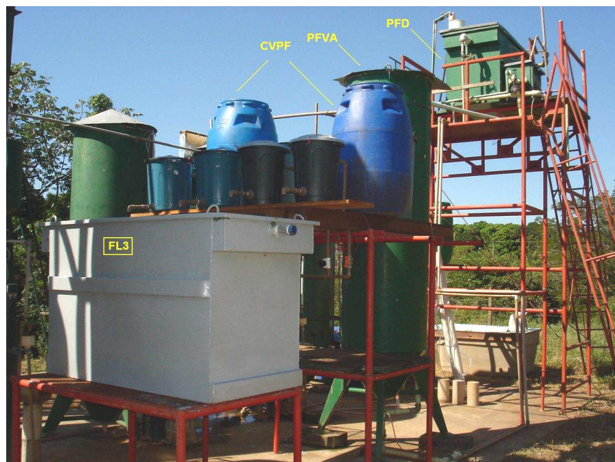
Figura 4.2 – Vista geral (2) da estação piloto.
