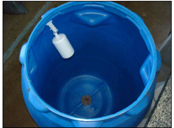
Figura 4.13 – Reservatório de 200L com bóia para controle do nível d'água.
