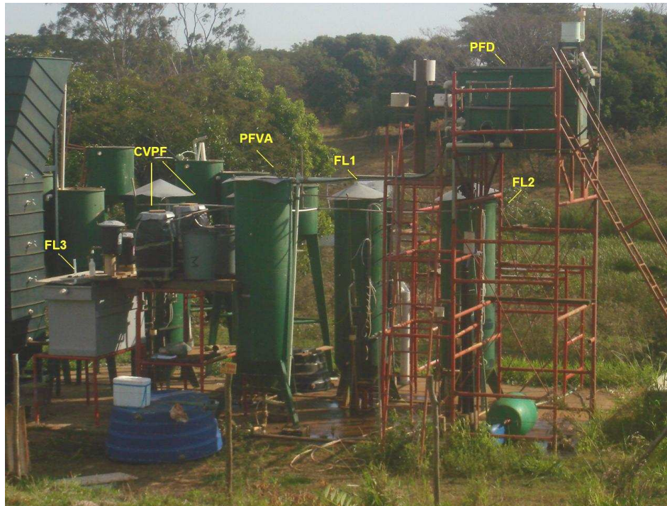
Figura 4.1 – Vista geral (1) da estação piloto.
