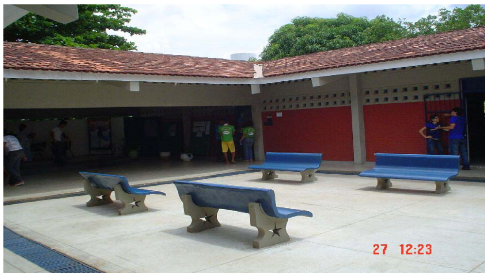
Figura 3: Pátio da escola com as salas de aula ao redor
